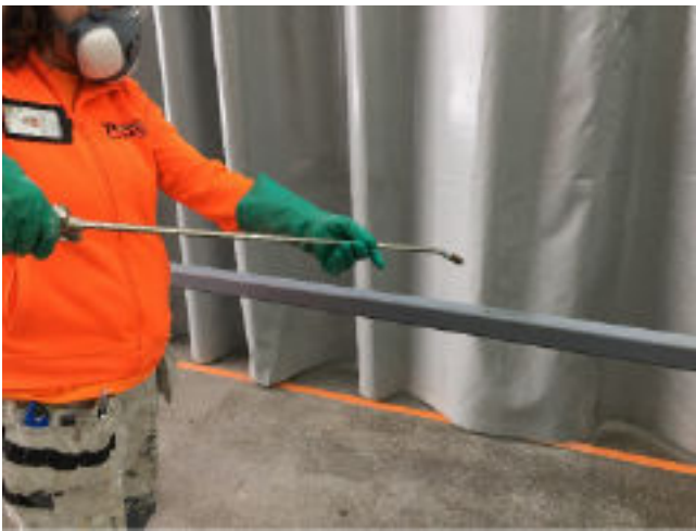
Kuva 3. Maalattavat pinnat pestään
