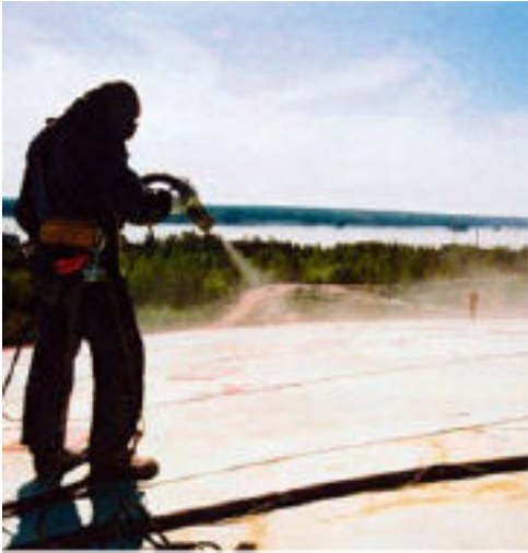
Kuva 4. Maalattava pinta suihkupuhdistetaan
