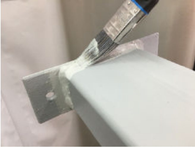
Kuva 7. Hitsiliitoksen ja särmän vahvennusmaalaus
