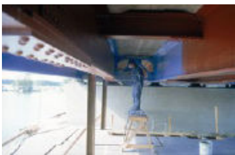
Kuva 5. Poikkeavat värisävyt helpottavat maalaustyön arviointia
