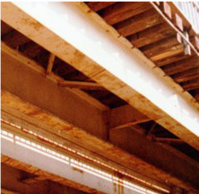
Kuva 1. Etualalla olevan palkin alapinta on ruostumisasteessa Ri 3 ja taaempana olevat ruostumisasteessa Ri 4
