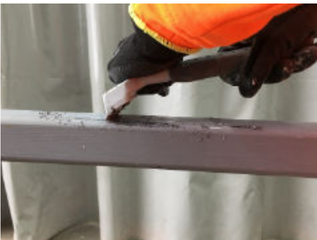
Kuva 6. Maali ja irtonainen ruoste kaavitaan pois
