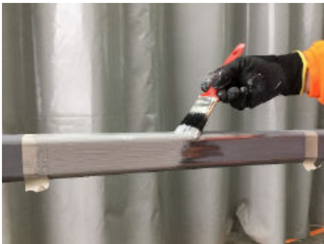
Kuva 9. Paikkausmaalauk tehdään siveltimellä
