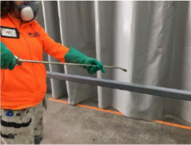
Kuva 5. Paikattava alue pestään
