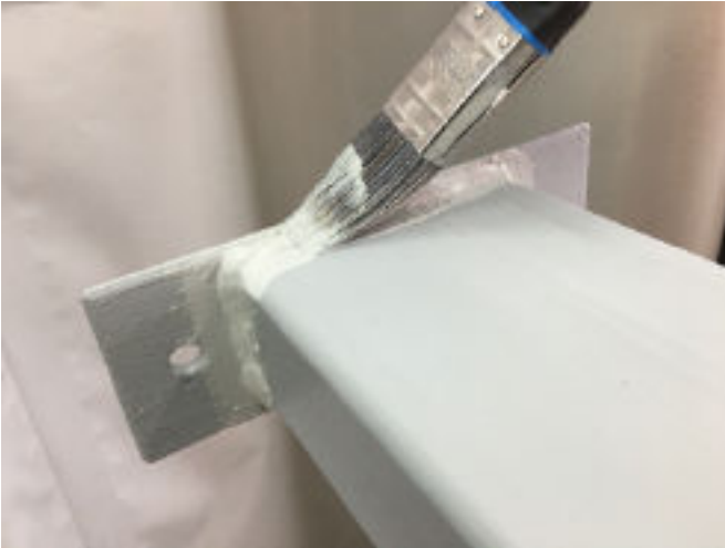
Kuva 10. Hitsiliitoksen ja särmän vahvennusmaalaus
