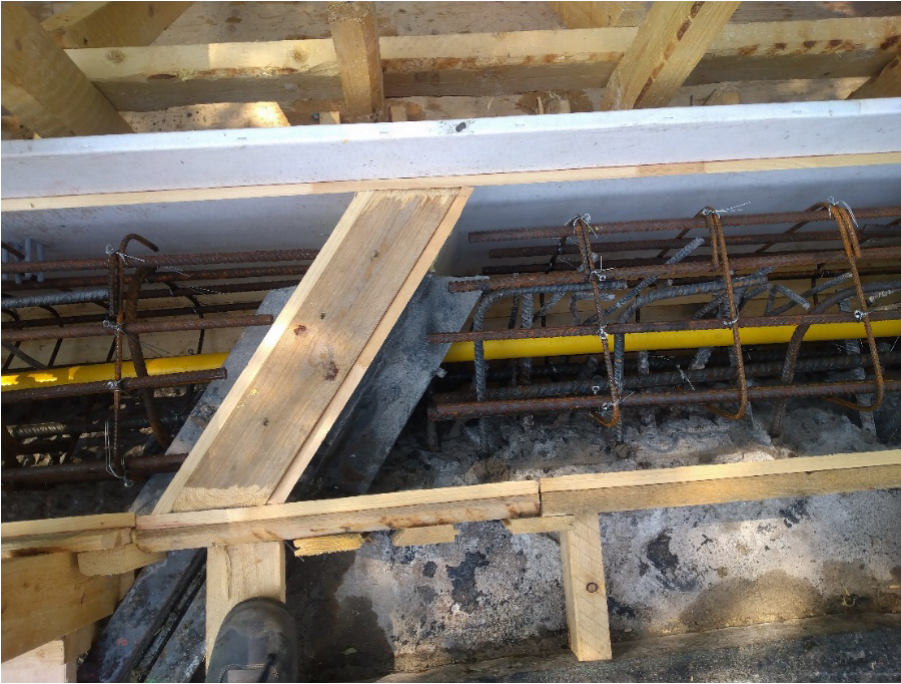
Kuva 13. Valmista raudoitusta sekä liikuntasauaman muotti
