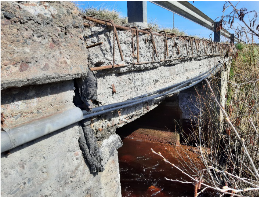
Kuva 1. Klorigirasituksen aiheuttamaa reunapalkin rapautumista (Taitorakennerekisteri)
