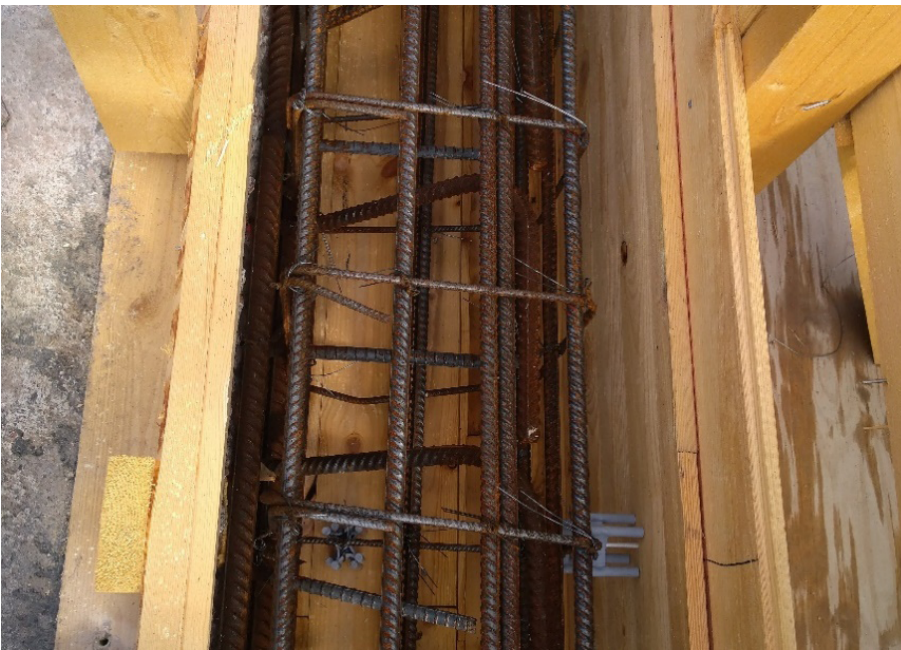
Kuva 14. Raudoitus on tuettu muovivälikkeillä muottiin
