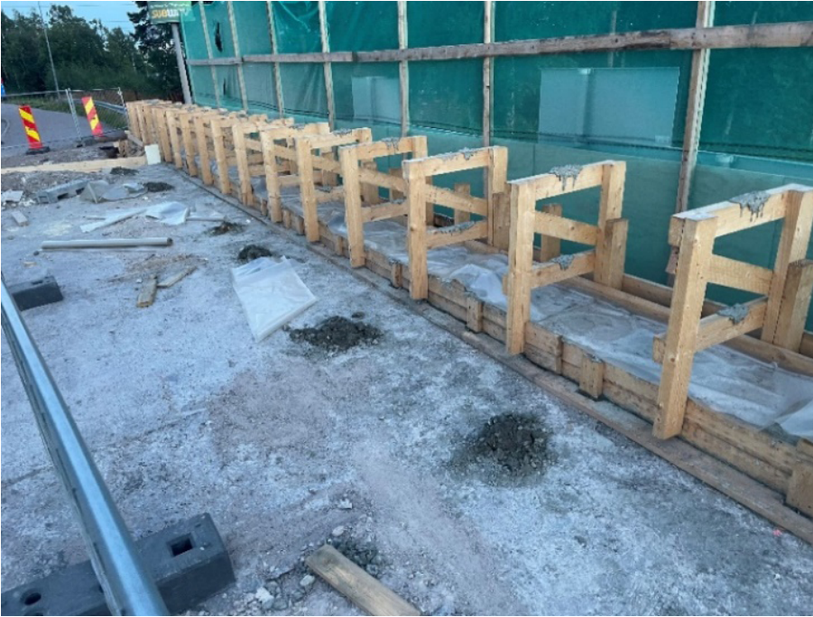
Kuva 17. Valu on suojattu muovikalvolla
