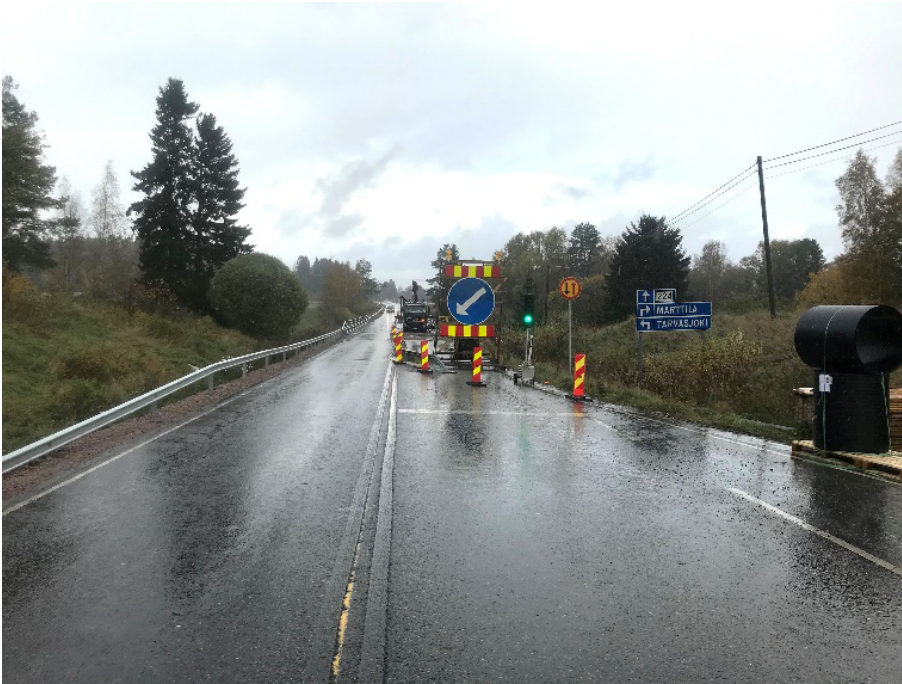
Kuva 4. Korjaustyömaan liikennejärjestelyjä
