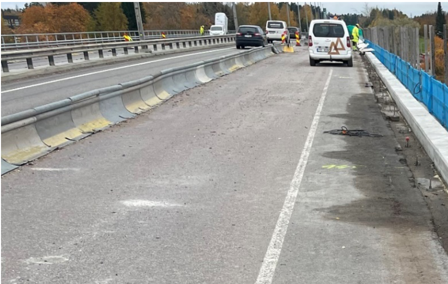
Kuva 5. Työmaa-alue on erotettu liikenteestä kaiteella
