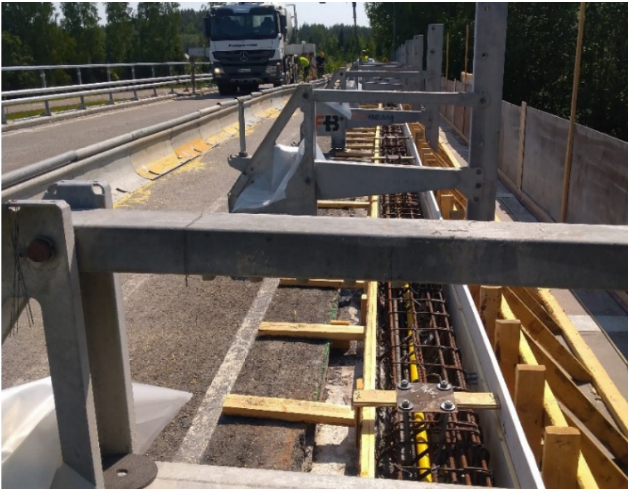
Kuva 9. Telineinä on käytetty siirrettäviä valmistelineitä
