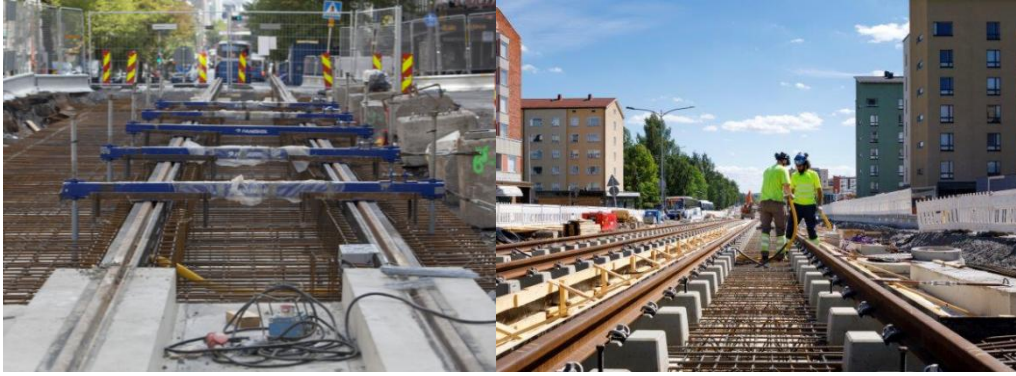
Kuva 11.3:1. Vasemmalla kiskot on tuettu jatkuvasti ja oikealla pistemäisesti [11]-
