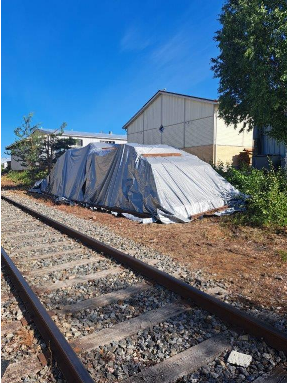
Kuva 1. Viimeisenä kasan päällä asetettu suojapeite ohjaa sadevedet pois.
