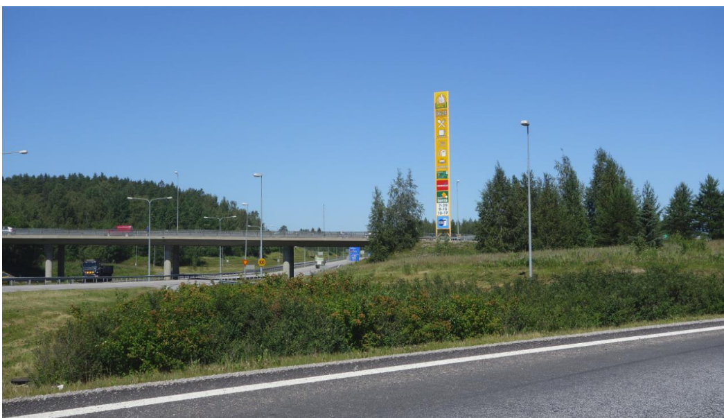
Kuva 4. Esimerkkikuva valtatie eritasoliittymäalueesta rampilta katsottuna.
