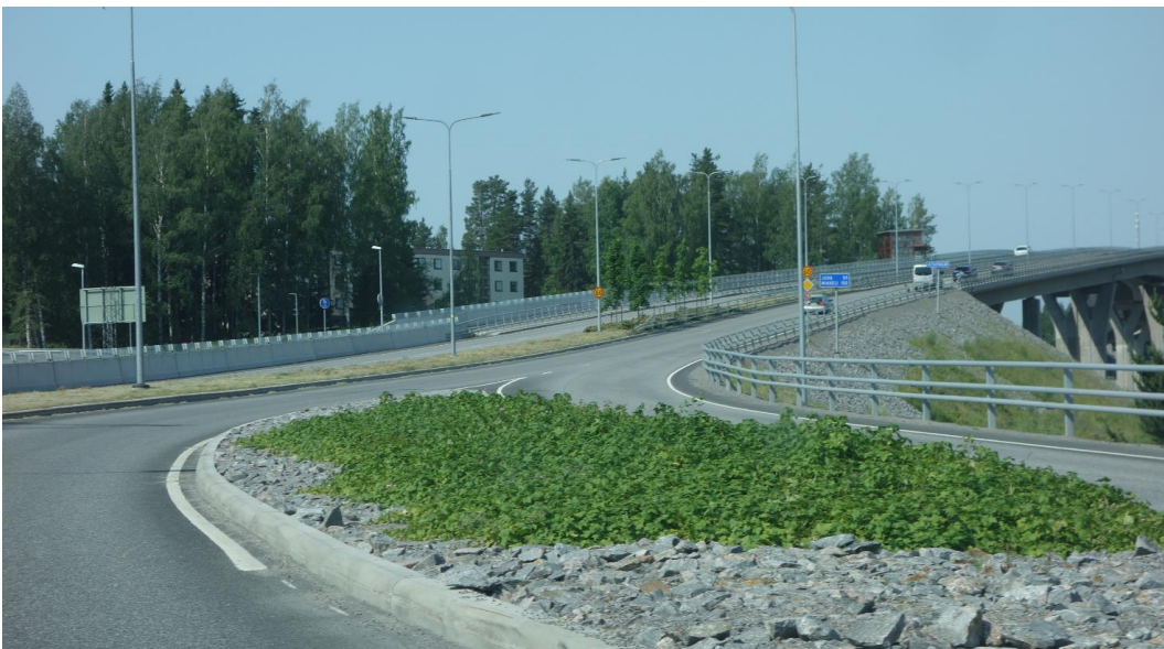
Kuva 6. Esimerkki valtatie siltaympäristöstä, jossa on suuri vesistösilta.
