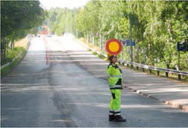
Kuva 12. Korjattava kaista suljetaan liikenteeltä
