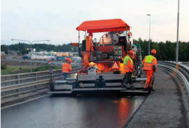
Kuva 20. Valuasfalttipäällysteen levitys
