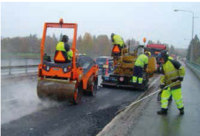
Kuva 19. Asfalttipäällysteen levitys
