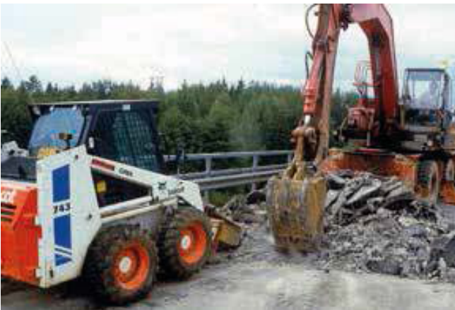
Kuva 16. Pintarakenteiden purku kaivinkoneella
