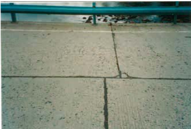
Kuva 2. Sillan betoninen ajotielaatta
