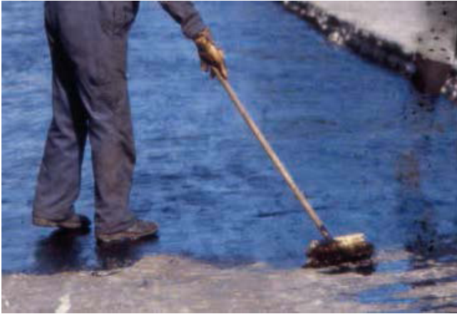
Kuva 18. Tartunta-aine levitetään harjaamalla
