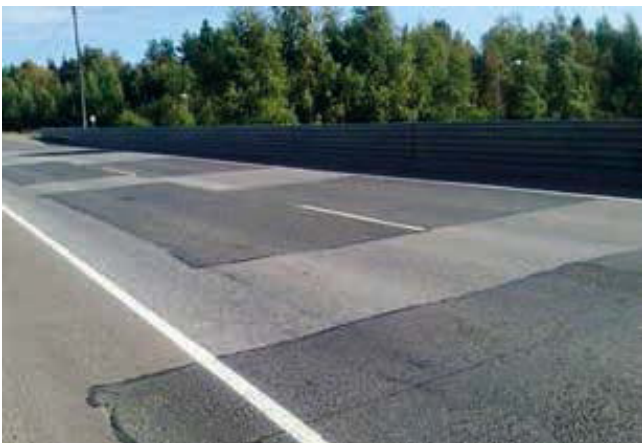
Kuva 4. Paikattu asfalttipäällyste
