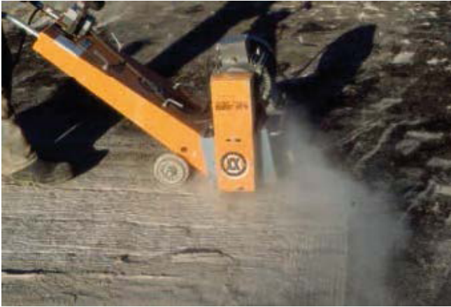
Kuva 17. Korjauskohteen reuna viimeistellään kevyellä jyrsimellä
