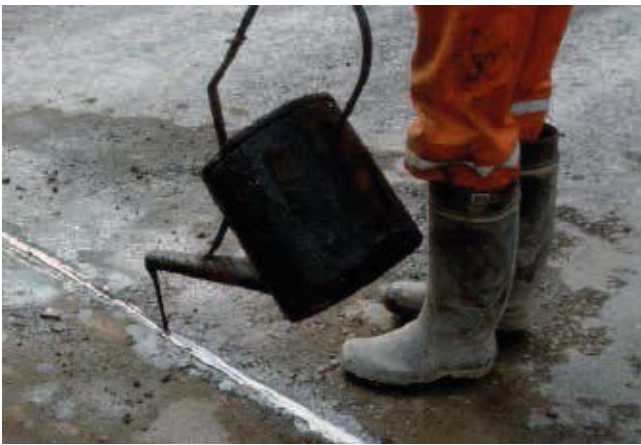
Kuva 23. Saumaus kumibitumimassalla kannukaatomenetelmällä
