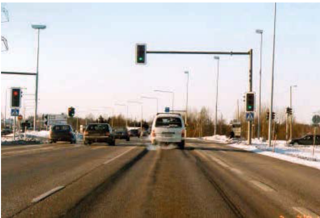
Kuva 7. Deformaatiovaurioita asfalttipäällysteessä
