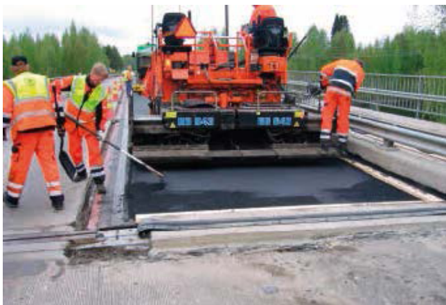
Kuva 24. Päällysteen liitos liikuntasaumalaitteeseen
