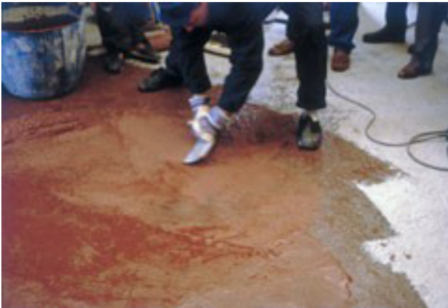
Kuva 15. Vedeneristyksen alusta on paikattu kuumuuttakestävällä juotosmassalla
