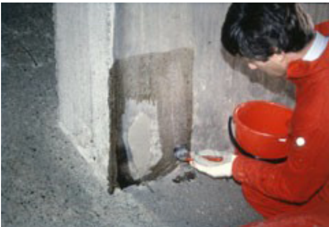
Kuva 14. Pienen kolon paikkaus on tehty paikkausmassalla
