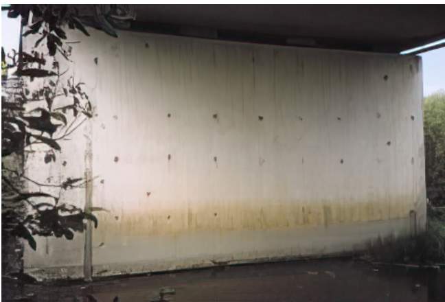
Kuva 7. Irronneita paikkauksia
