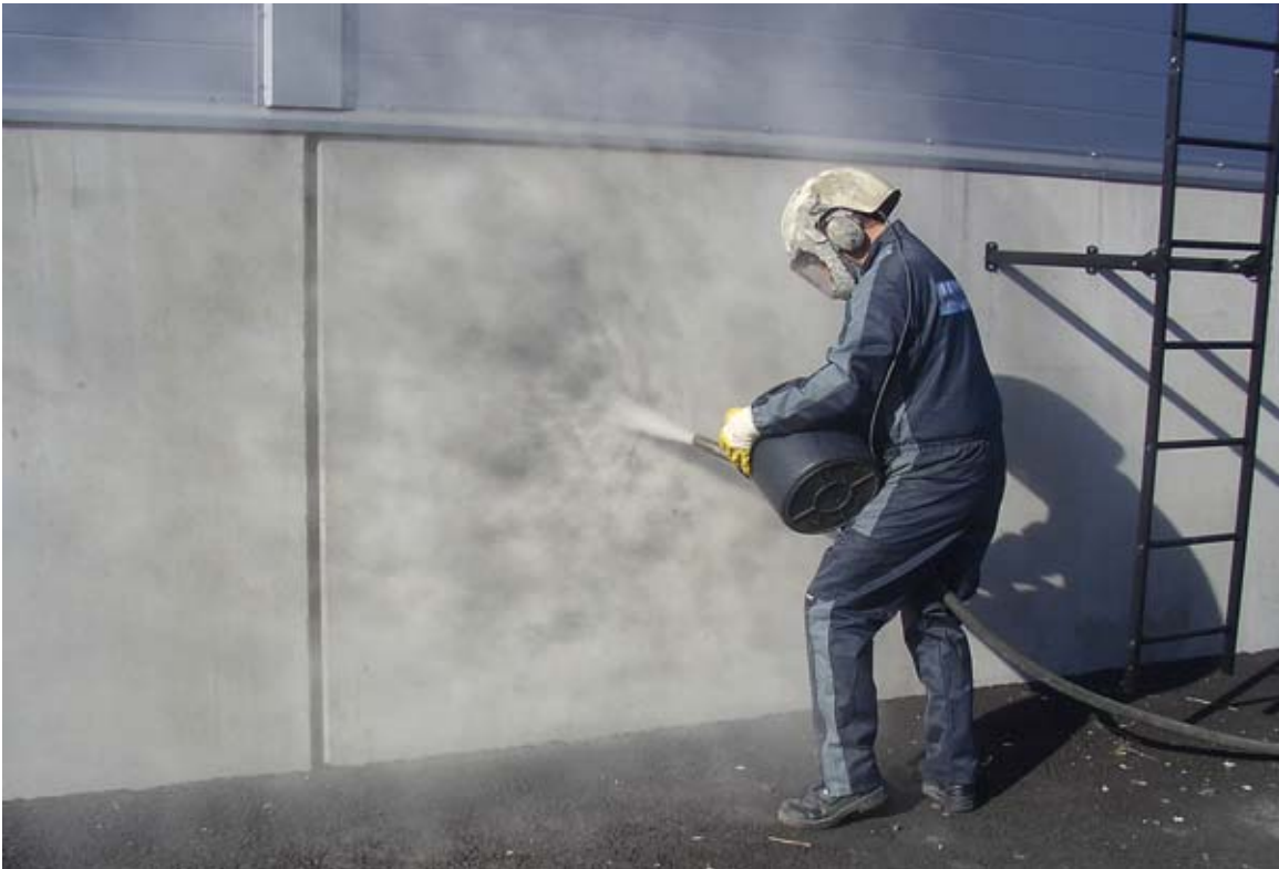
Kuva 23. Paikkausta ejektorilla
