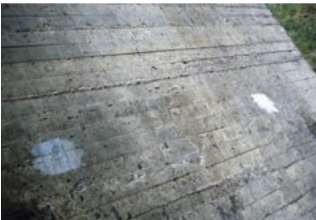
Kuva 24. Ympäristöstään häiritsevästi erottuva paikkaus
