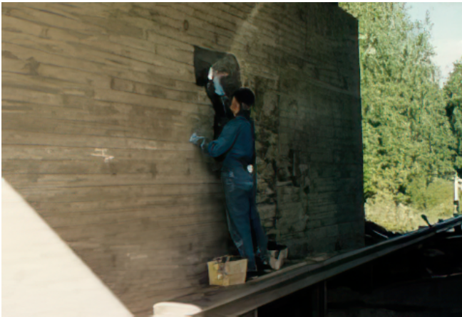
Kuva 12. Paikkausta pystypintaan valumattomalla paikkauslaastilla
