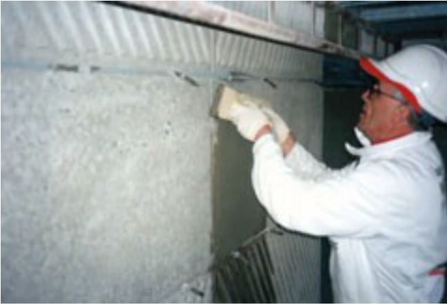
Kuva 19. Paikkaus valumattomalla laastilla
