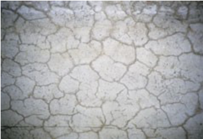
Kuva 8. Halkeillut paikkaus
