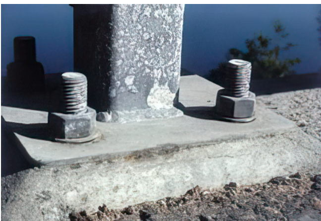
Kuva 13. Kaidepylvään juurikoroke on valettu juotoslaastista
