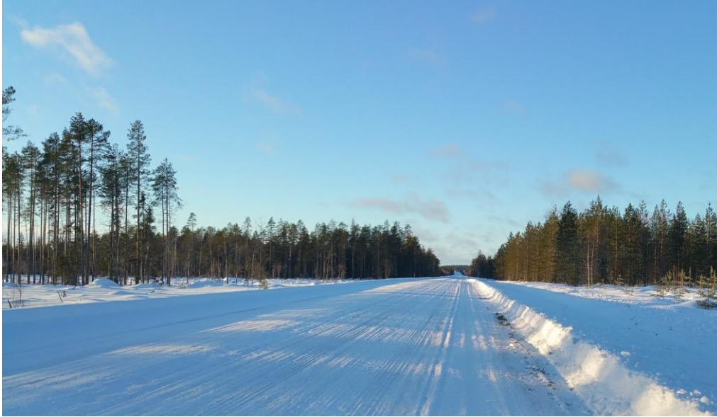
Kuva 11. Aurasviittojen puuttumisesta johtuva yliauraus.
