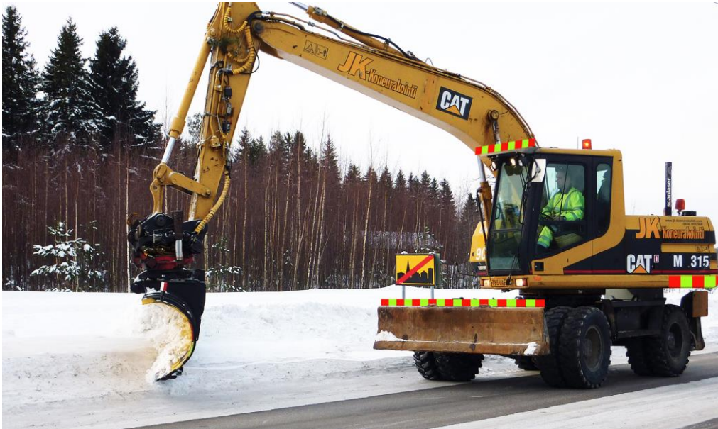
Kuva 36. Vallien madallusta kaivinkoneella.
