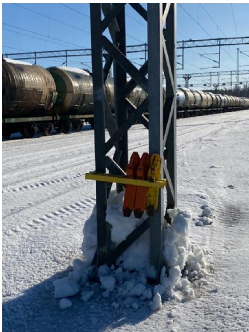
Kuva 2. Asennus ristikkopylvääseen.
