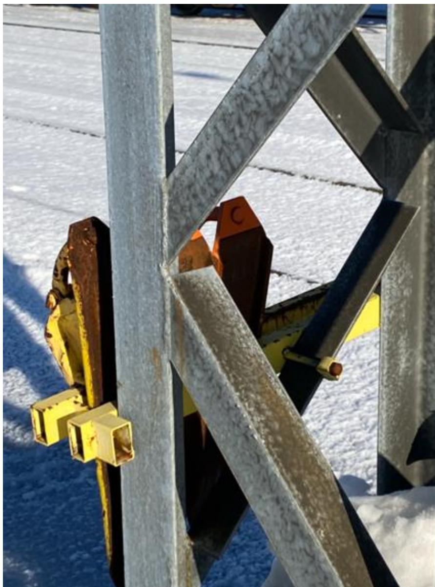
Kuva 3. Hakapulttiasennus ristikkopylvääseen.
