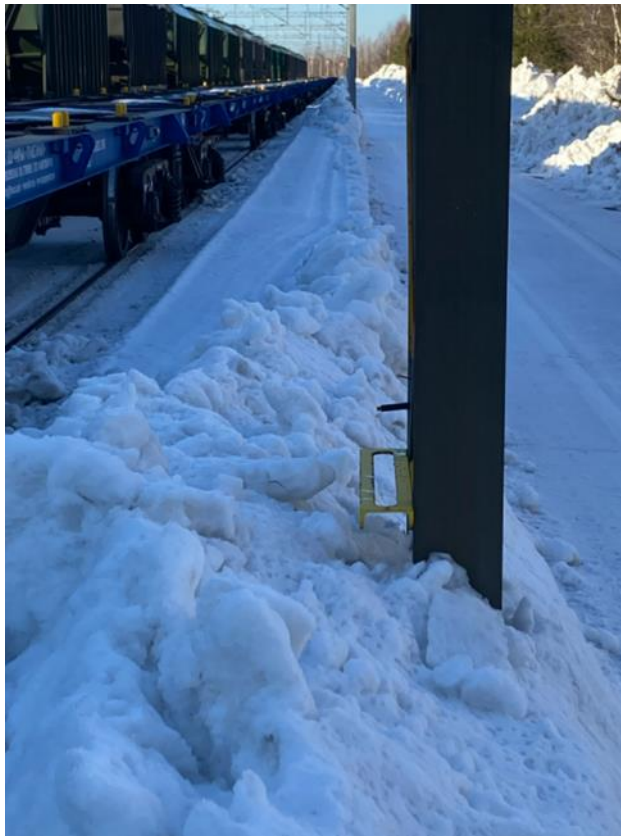
Kuva 1. Pysäytyskenkäteline väärin asennettuna lumenaurauksen vallipaikalle.
