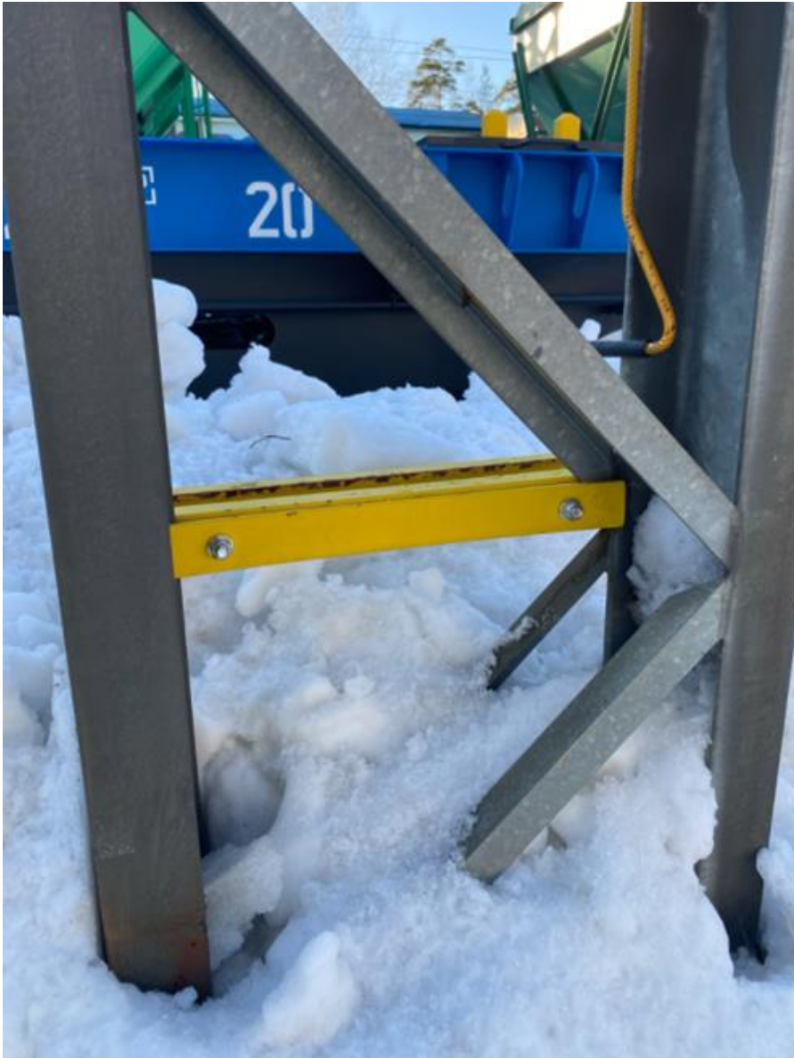
Kuva 4. Asennus puristamalla P-pylvääseen.
