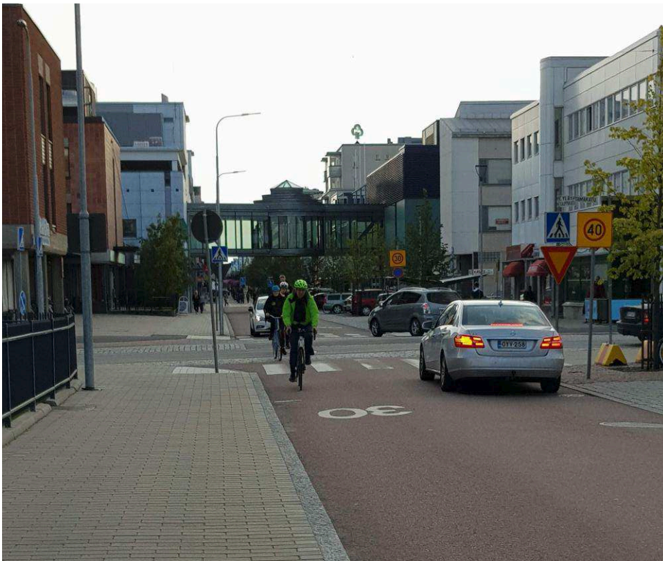
Kuva 115 Joensuussa pyöräkatuna toimivan Kauppakadun poikkileikkaus säilyy muuttumattomana etuoikeutetun Yläsatamakadun ylityksen jälkeen. Risteyksestä puuttuu toistaiseksi Pyöräkatu (E28) ja Pyöräkatu päättyy (E29) -liikennemerkki (kuva Reijo Vaarala).
