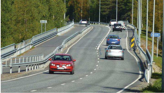
Kuva 29 Kaiteen käyttö sillan kohdalla Taivalkoskella valtatiellä 20 (kuva Reijo Vaarala).
