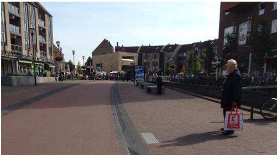
Kuva 55 Luiskattu reunakivi muodostaa turvallisen tasoeron pyörätien ja jalkakäytävän välille (kuva Niko Palo).
