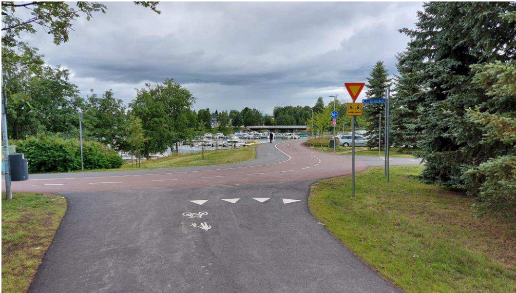
Kuva 160 Risteävän suunnan yhdistetty pyörätie ja jalkakäytävä määritetään väistämisvelvolliseksi korkeatasoisen pyöräliikenteen väylän (baanan) risteyksessä (kuva Reijo Vaarala).
