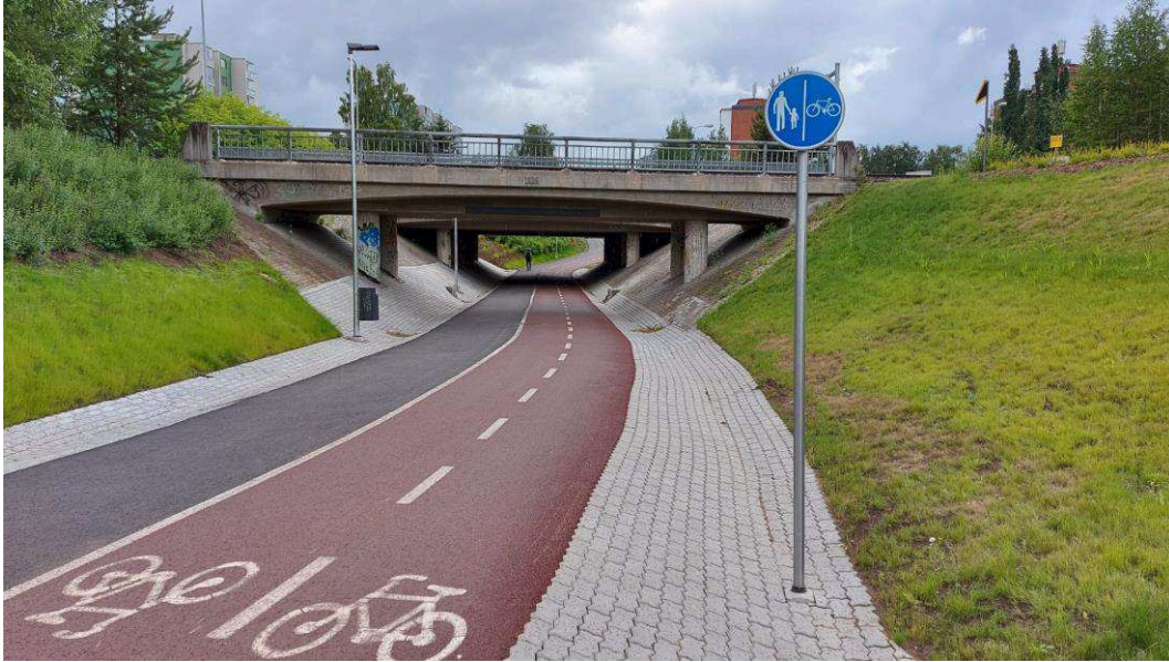
Kuva 165 Jalankulun erottelu pyöräliikenteestä alikulussa, Bertel Jungin tie Oulussa. Kuvan liikennemerkistä puuttuu Kaksisuuntainen pyörätie (H23.1) -lisäkilpi (kuva Reijo Vaarala).
