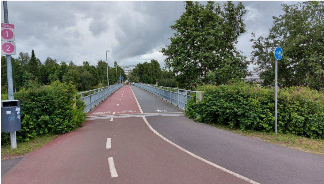
Kuva 166 Pokkisenväylän ylittävä Tervaporvarinsilta Oulussa. Kuvan liikennemerkistä puuttuu Kaksisuuntainen pyörätie (H23.1) -lisäkilpi (kuva Reijo Vaarala).
