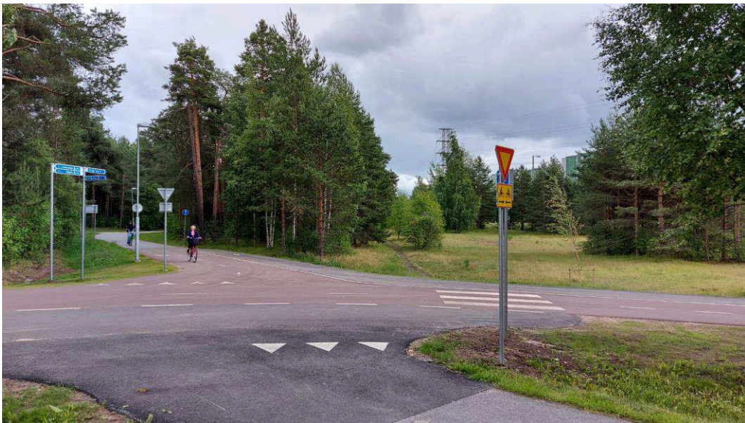
Kuva 161 Pyöräteiden keskinäisten risteysten liikennemerkillä osoitettua väistämisvelvollisuutta voidaan tehostaa tiemerkinnoin (kuva Reijo Vaarala).
