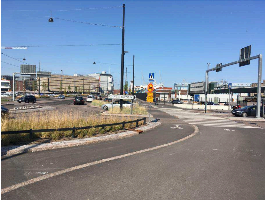
Kuva 138 Pyöräliikenteen kiertotila on ympyrän muotoinen. Kuivatusratkaisu tarjoaa laadukkaan siirtymisen ajoradan yli (kuva Niko Palo).
