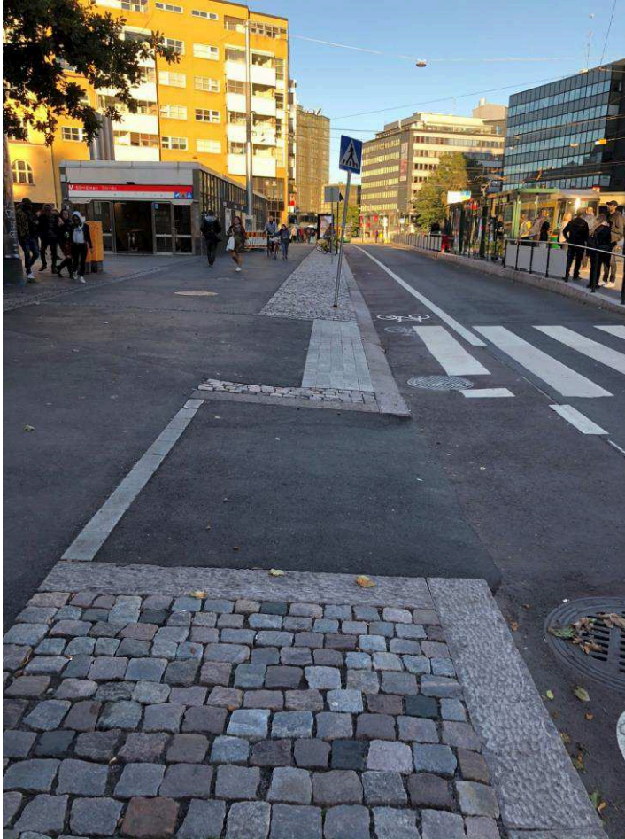
Kuva 200 Pyöräilijän ylityskohta suojatien rinnalla voidaan toteuttaa laadukkaasti rakentamalla siirtymäluiskan suuntaiset reunatuet.
