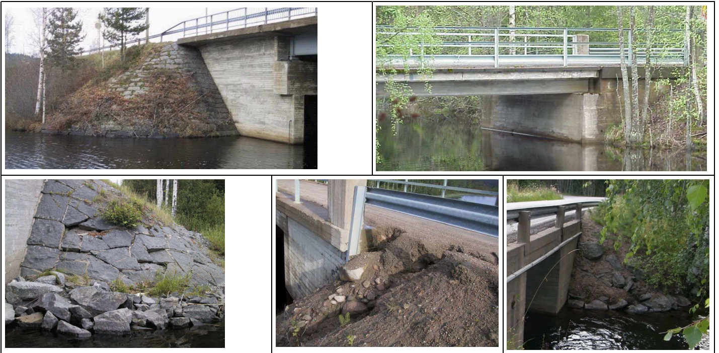
Kuva 22. Ylärivissä vasemmalla sillan keila pitää puhdistaa (B). Ylärivissä oikealla sillan keilat on puhdistettava vesakosta (B), mutta keilan puuston vuoksi vuositarkastusmerkintä tulee myös D-sarakkeeseen. Alarivissä vasemmalla on alle 2 m 2 :n purkautuma (C). Alarivissä keskellä on paha eroosioaurio, joka vaarantaa liikenneturvallisuu- den, joten välittömästi ilmoitus tilaajalle ja merkintä D-sarakkeeseen. Alarivin oikeanpuoleisimmassa sillassa keila vaatii puhdistuksen (B), jonka lisäksi keila on ehdotettava korjattavaksi ja puusto poistettavaksi (D).
