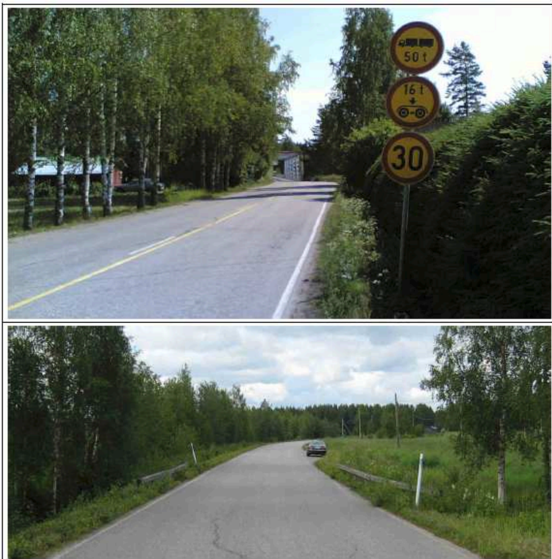
Kuva 19. Ylempään siltaan liittyvä liikennemerkki on hyvässä kunnossa – taulut ovat puhtaat ja pylvään kallistuma sallituissa rajoissa, joten sillan vuositarkastaja kirjaa havainnon A-sarakkeeseen. Alemman sillan reunapaalut ovat liian vinossa, joten vuositarkastusmerkintä tulee C-sarakkeeseen.
