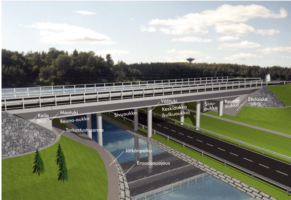
Kuva 1. Sillan alusrakenteet ja silta-alueen rakenteet.
