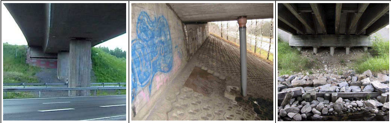
Kuva 21. Vasemmanpuoleisimman sillan tapauksessa etuluiska alkaa osoittaa jo heinittymisen merkkejä, joten vuositarkastusmerkintä tulee B-sarakkeeseen. Keskimmaisessä sillassa etumuurin edessä on alle 2 m 2 :n kokoinen sidekiveypurkautuma, joten vuositarkastusmerkintä kuuluu C-sarakkeeseen. Oikeanpuoleisin silta on selkeä D-tapaus etuluiskan osalta.
