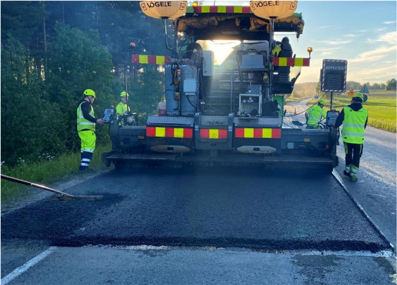
Kuva 6. Tienpäällystystyöt
