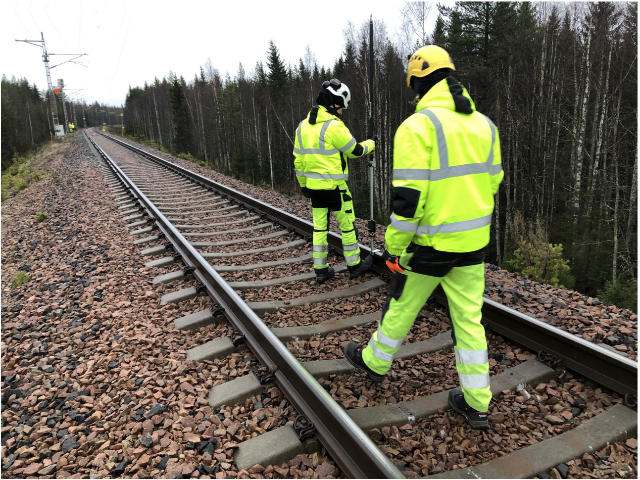
Kuva 4. Maasto- ja mittaustyöt
