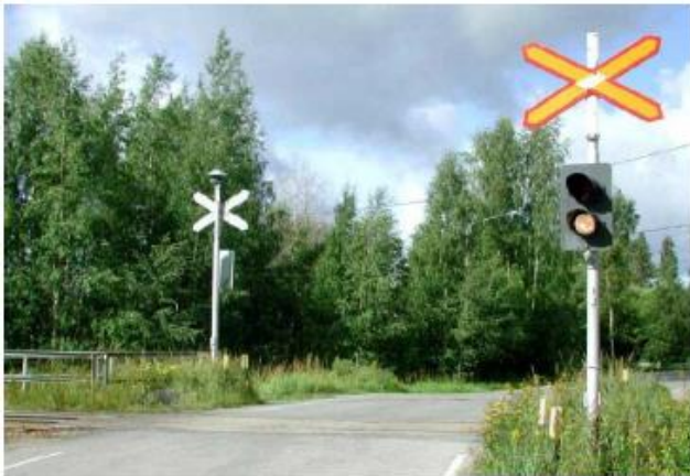
Kuva 5. Valo- ja äänivaroituslaitteet (kuva Hytönen 2001)
