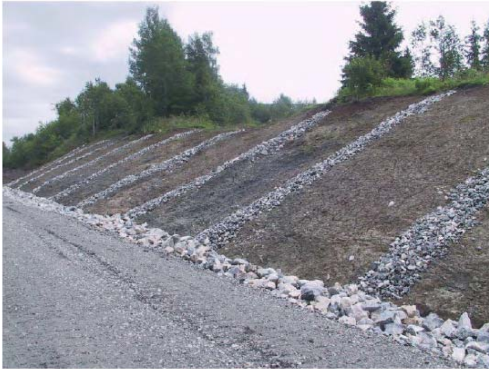
Kuva 8.12 Valmis suojausrakennelma ja kivilalaojat /(Håndbok 274, Statens vegvesen 2008-4)
