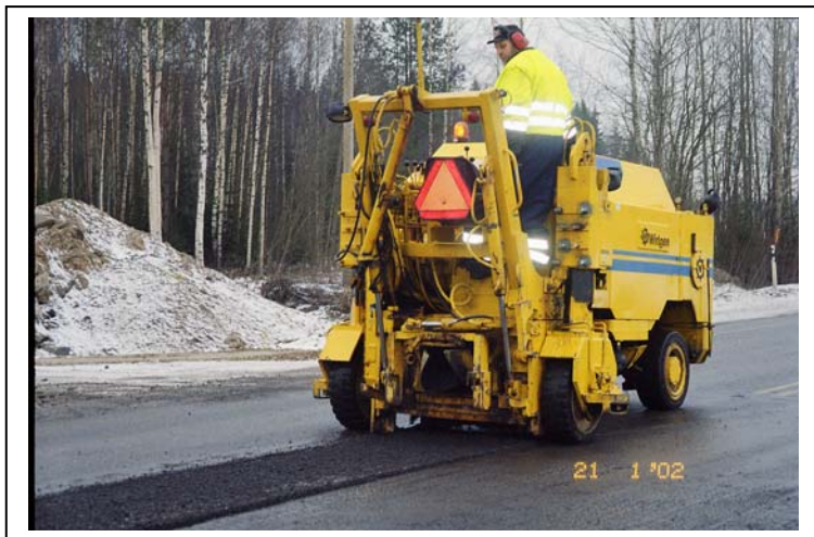
Kuva 17. Asfalttipinnan vauriokohdan kylmäjyrsintä.
