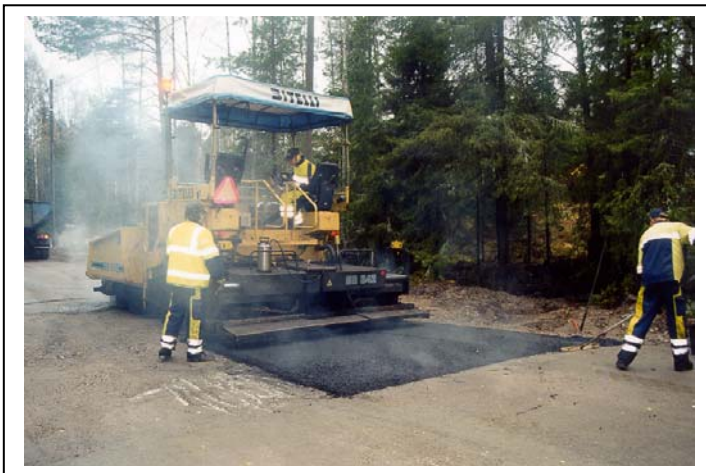
Kuva 4 Asfalttibetonipaikkaus konetyömenetelmällä.
