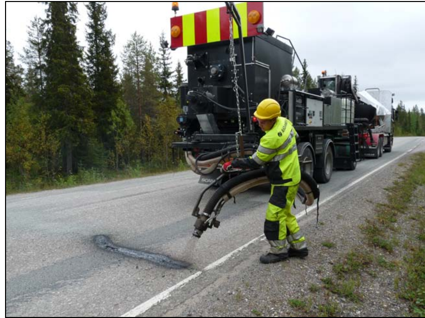
Kuva 8. Sirotepuhalluspaikkaus.
