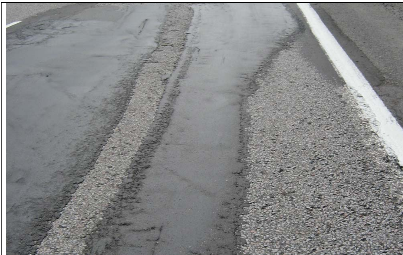
Sileäpintainen, kiiltävä paikka moottoritien ramppisillalla.
