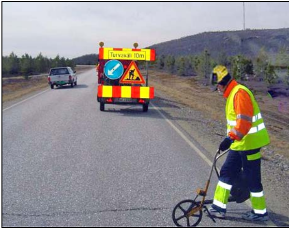
Kuva 15. Halkeaman korjaus kannukaatosauausmenetelmällä.
