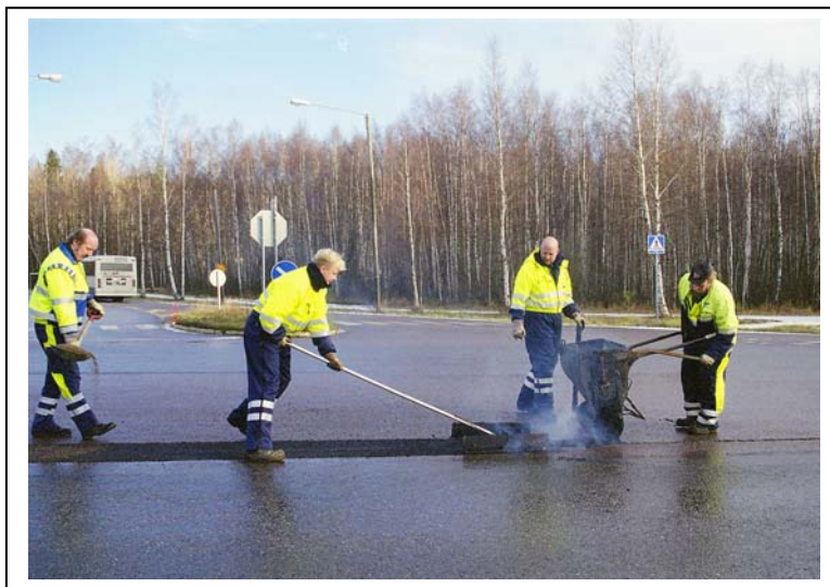
Kuva 5. Valuasfalttipaikkaus käsityömenetelmällä.
