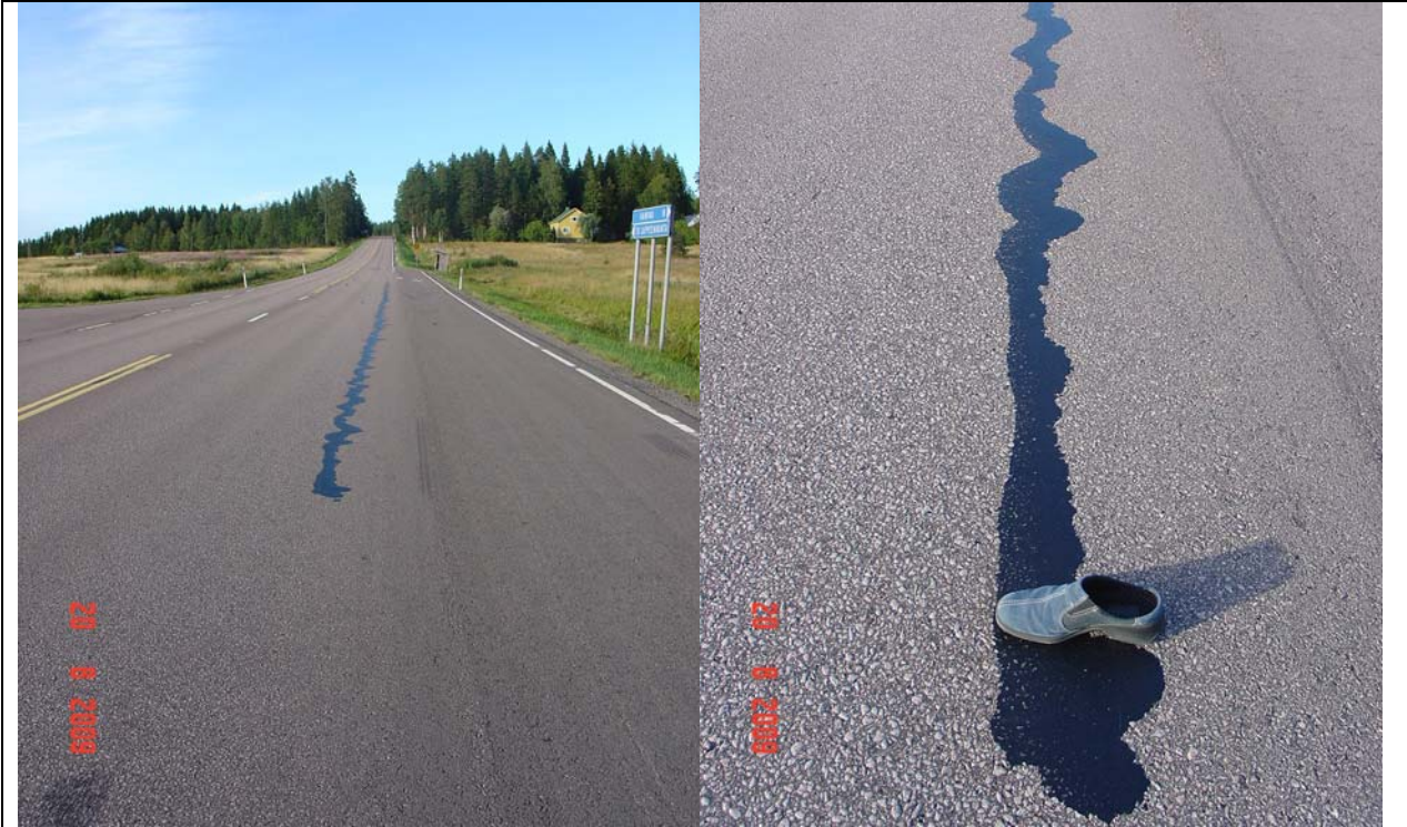
Pitkän bitumijuotoksen kitka mitattu ennen juotosta, sen kohdalta ja jälkeen.
