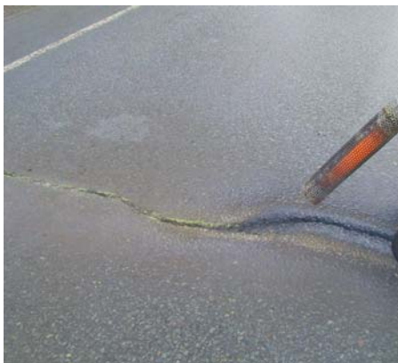
Kuva 13. Puhalluskuumennus.
