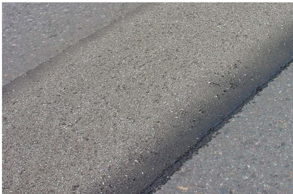
Kuva 18. Karkeutettu paikkauksen pinta.
