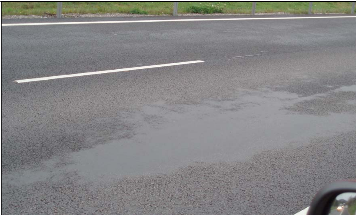
Uuden SMA-päällysteen bitumin pintaannouskohta moottoritiellä
