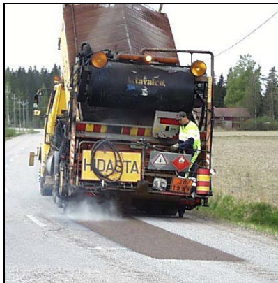
Kuva 7. Sirotepaikkaus.
