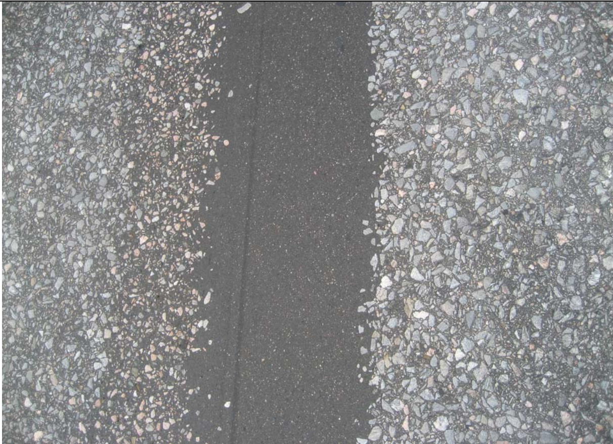
Hienorakeinen karkeutuskiviaines moottoritien rampin ajouran paikkauksen pinnassa.
