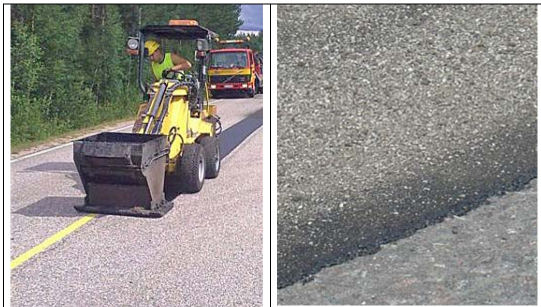
Kuva 6. KT-valuasfalttipaikkauksen levitys, tiivistys ja karkeutettu paikkaus.
