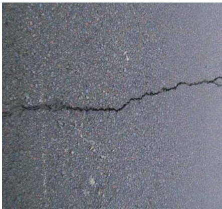
Kuva 11. Poikittainen halkeama.
