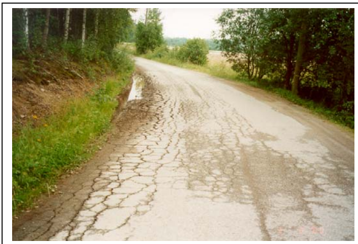
Kuva 2. PAB-päällysteen verkkohalkeamia.
