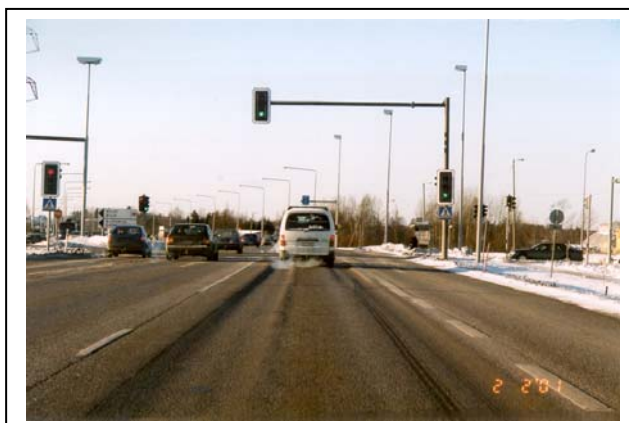
Kuva 1. Asfalttipäällysteen deformaatiouria.
