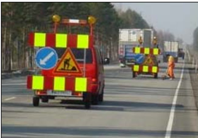
Kuva 16. Esimerkki kannukaatomenetelmän liikennejärjestelyistä.
