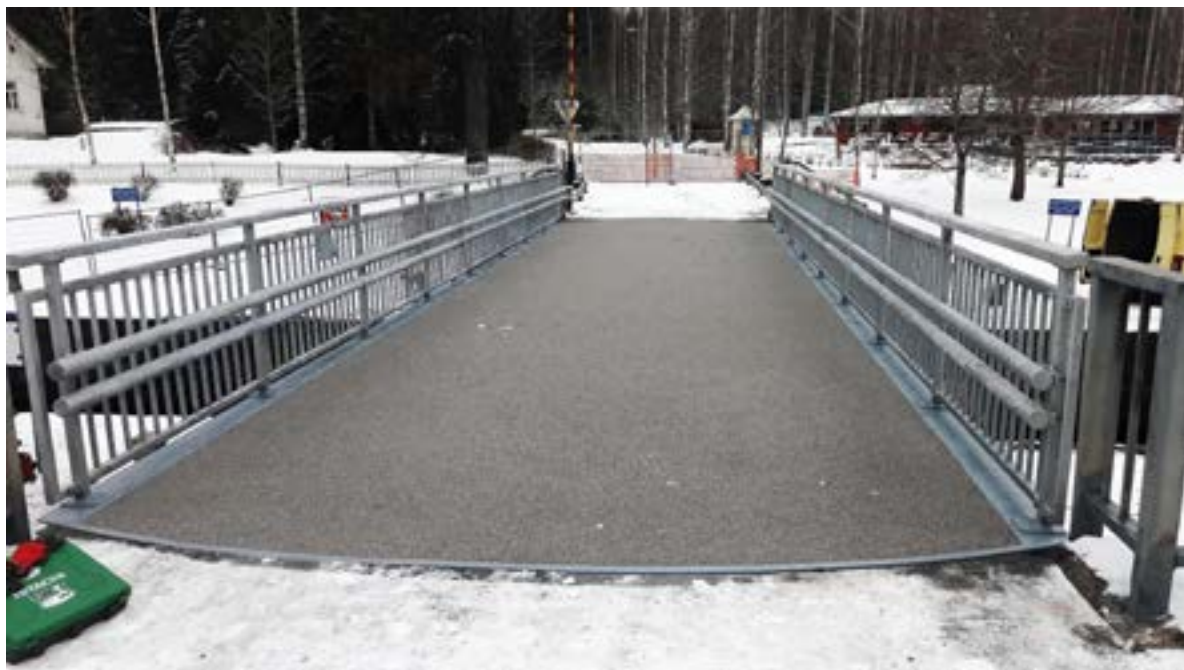
Kuva 1. Ohutkerrospäällyste Muroleen kanavan kääntösillalla (H-1214).
