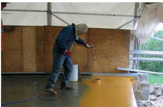
Kuva 2. Nestemäisenä levitettävän eristyksen ruiskutusta.
