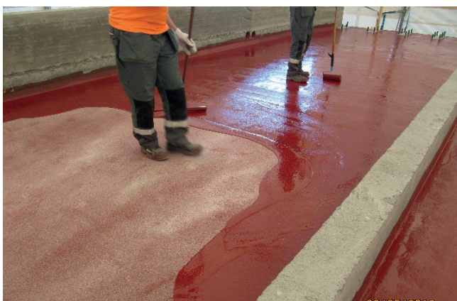
Kuva 1. Eristysalustan tiivistystä lastalla ja telalla.
