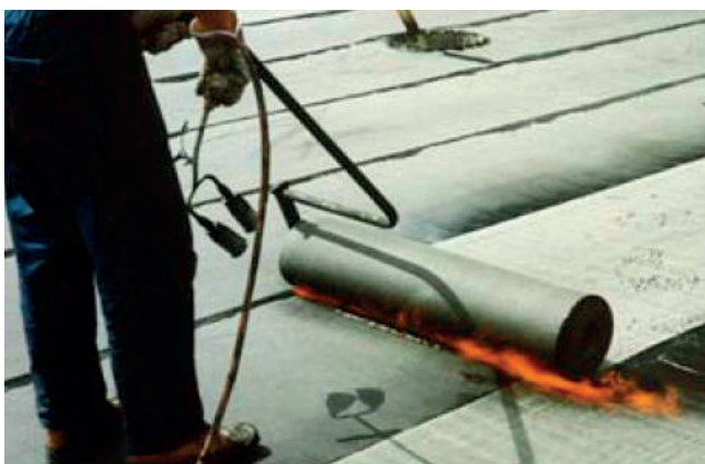
Kuva 2. Kermin kiinnitys kuumentamalla (hitsaamalla).
