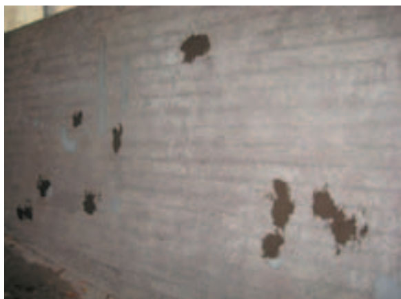
Kuva 1. Paikkauksia ennen alustan esikäsitteilyä.
