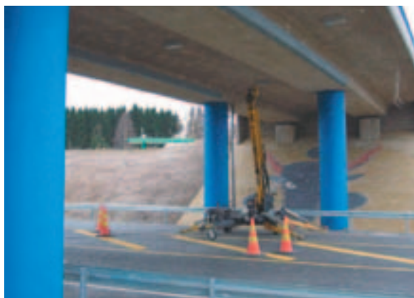
Kuva 3. Välituet suojattu värikkäällä pinnoitteella.
