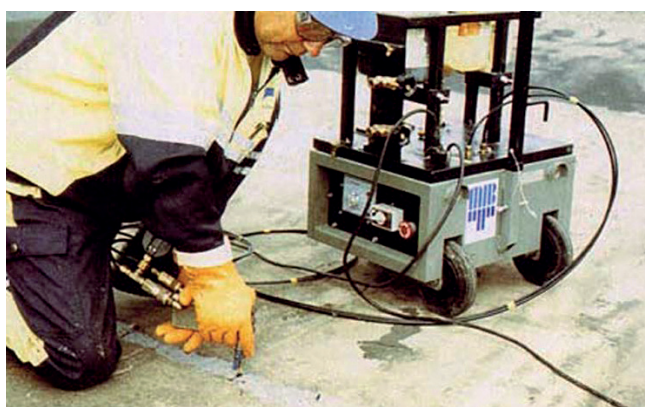
Kuva 1. Epoksi-injektoinnilla saadaan rakenteellinen lujuus.
