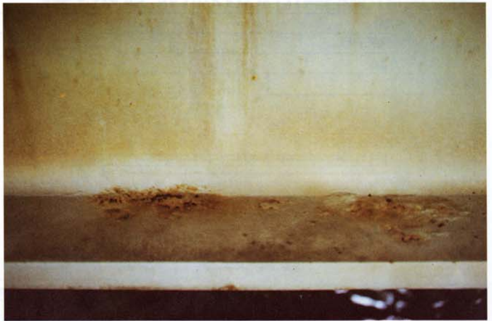
Kuva 4. Uuman ruostumisaste on Ri 1-2; 95 % ja Ri 3; 5%. Laipan ruostumisaste on Ri 1-2; 20 %, Ri 3; 70 % ja Ri 4; 10 %.
