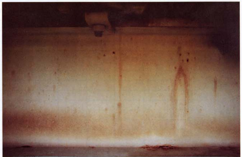
Kuva 5. Uuman ruostumisaste on Ri 1-2; 80 % ja Ri 3 20 %. Laippojen ruostumisaste on Ri 1-2; 40 %, Ri 3; 55 % ja Ri 4; 5 %.
