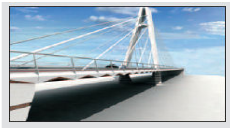
Kuva 5. Espanjaan uusiokiviaineesta tehtävä silta, suunnitelmakuva / 10 /.
