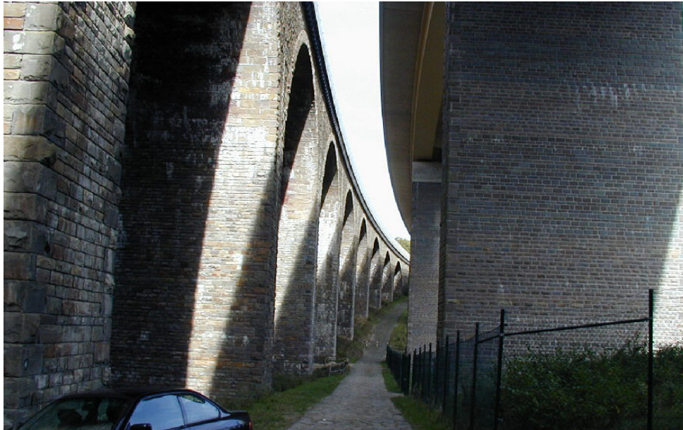
Kuva 4. Diepmannsbach-sillat. Vanha silta vasemmalla ja uusi uusiokiviaineesta tehty silta oikealla.
