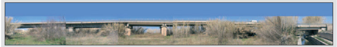
Kuva 6. Vanha silta, josta tehdään uusiokiviainesta uuteen siltaan / 10 /.
