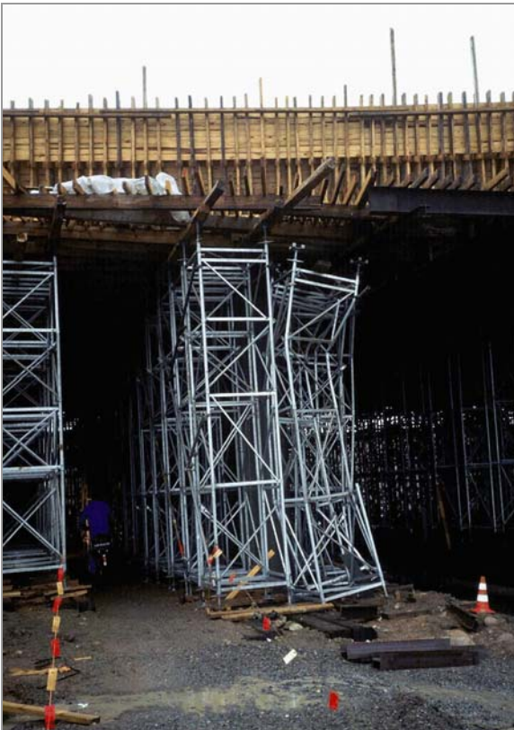
Kuva 2: Törmäys telineisiin
