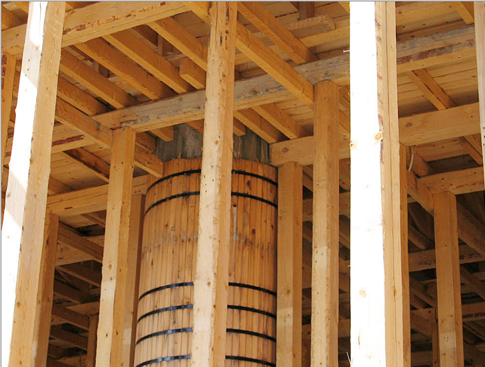
Kuva 15: Niskojen kiilaus pilaria vasten Marjamäen sillassa
