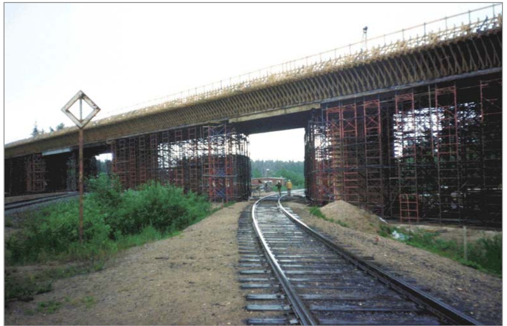
Kuva 13: Kulkuaukkoja kalustotelineissä
