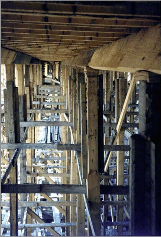
Kuva 1: Niskojen kiepahdus
