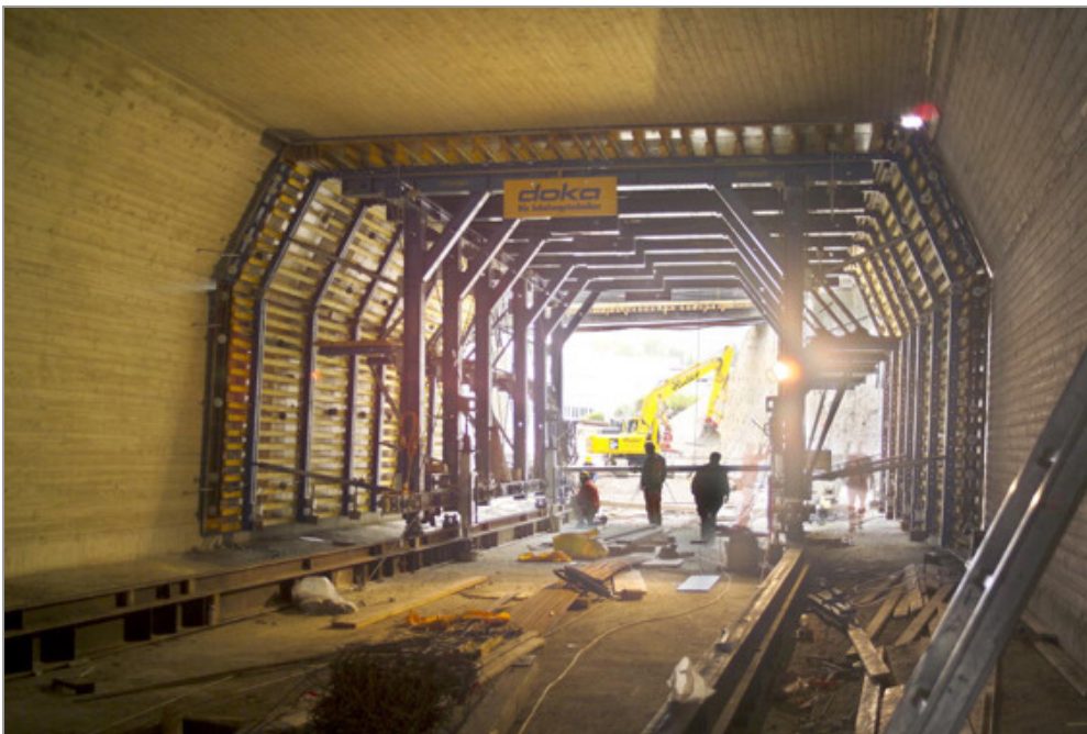
Kuva 44: Siirtoradalla vaiheittain etenevä tunnelimuotti
