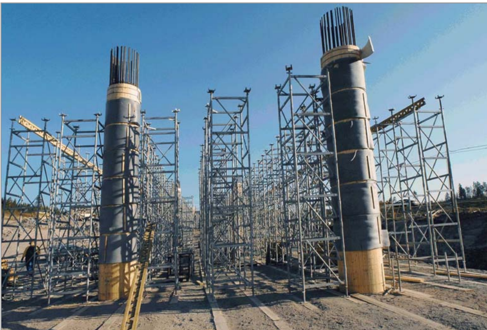
Kuva 12: Kalustotelineitä ja pilarimuotteja
