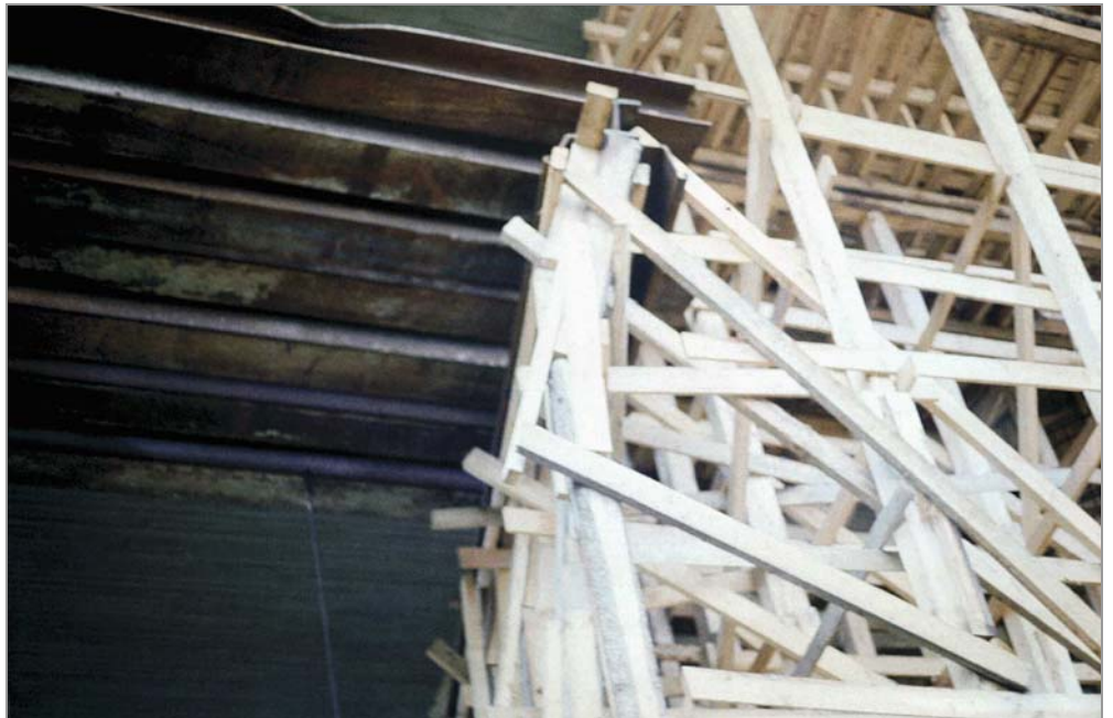
Kuva 4: Tolpan jatkos kulkuaukon reunalla
