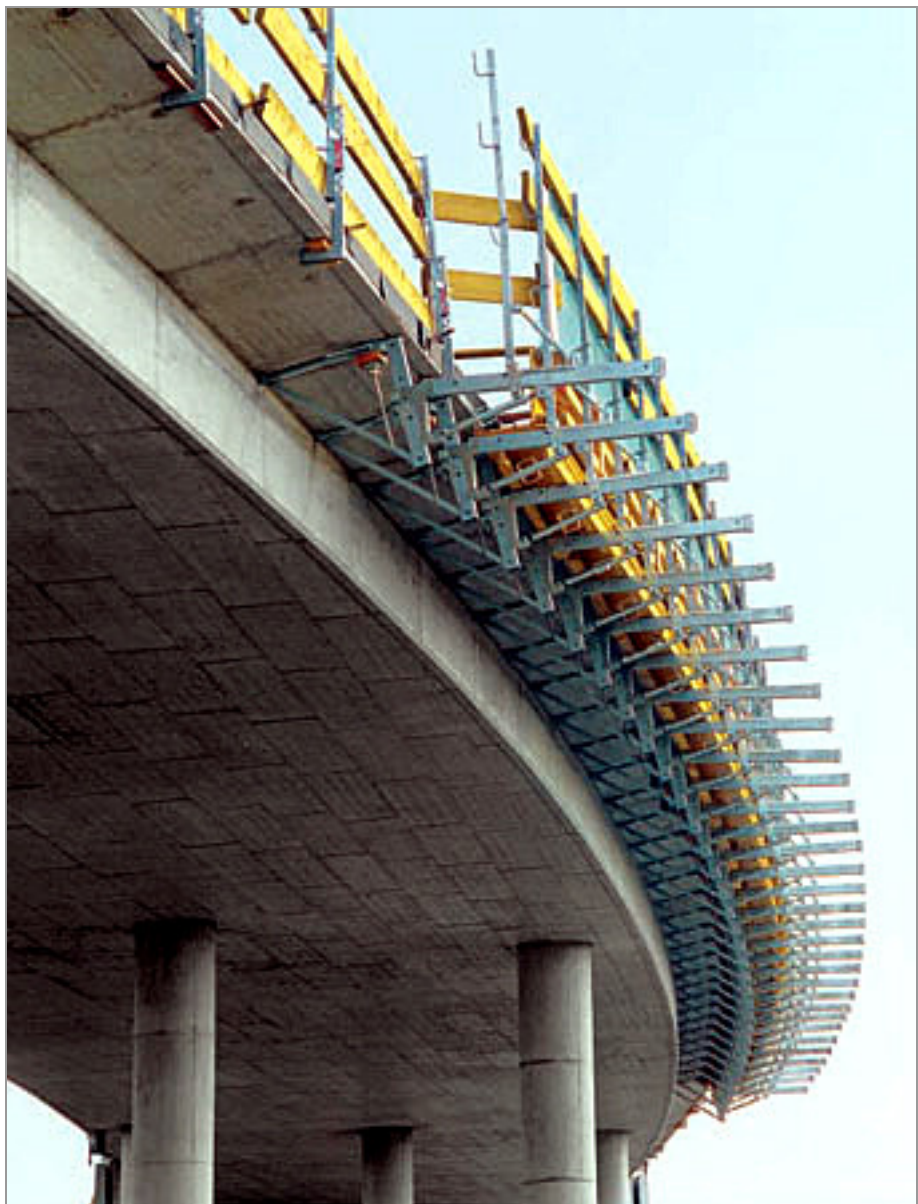
Kuva 46: Reunapalkin korjaus- ja jälkivaluteline
