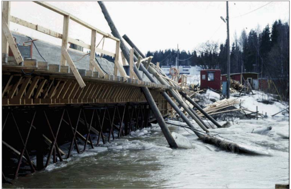
Kuva 7: Kevättulva kuormittaa Kortejoen sillan telineitä
