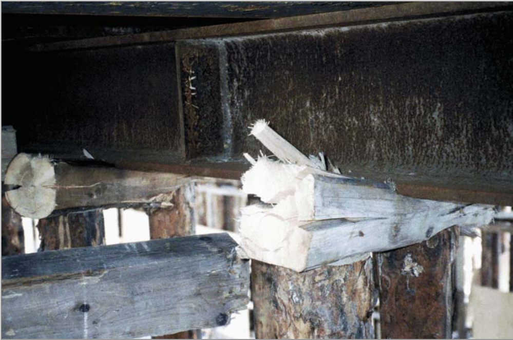
Kuva 5: Leimapaine ylittyy teräspalkin alla
