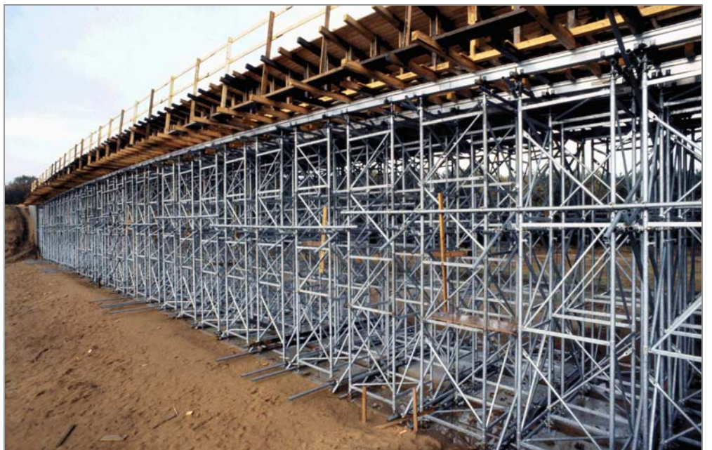
Kuva 10: Kalustotelineiden käyttöä
