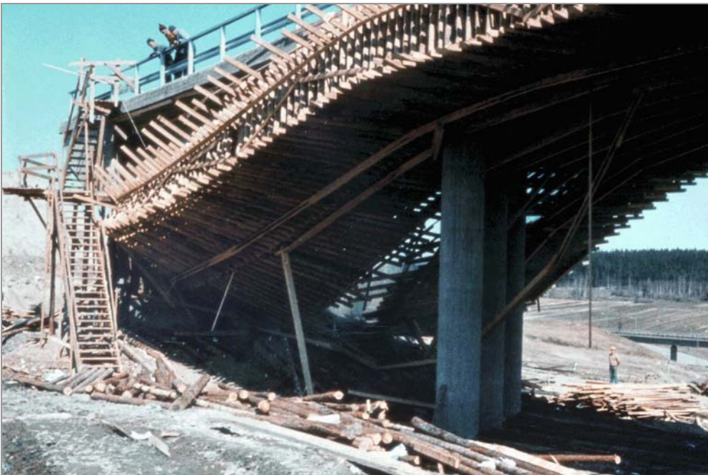
Kuva 6: Purkuvaiheen muotin irrotus
