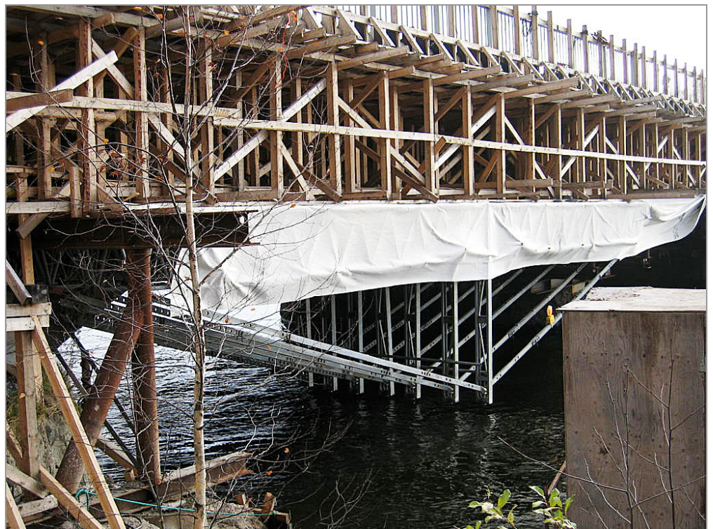
Kuva 14: Peiner V800 kannattimet ja puuteline Vammaskosken sillan korjauksessa
