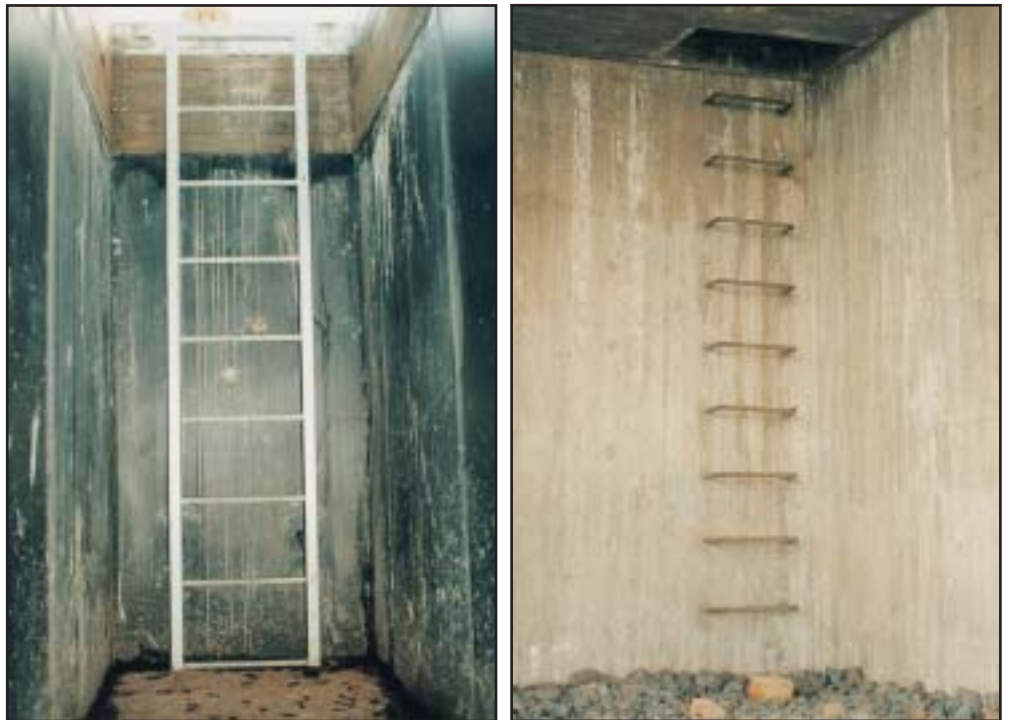
Kuva 10. Tikkaat maatuen sisä- ja ulkopuolella.
