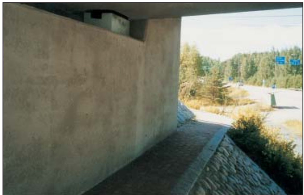
Kuva 11. Tarkastustasanteen mitoitus ja hyvin tehty tarkastustasanne.
