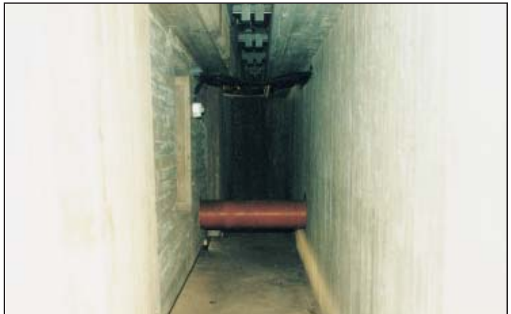
Kuva 5. Liikuntasauvan tarkastustila.
