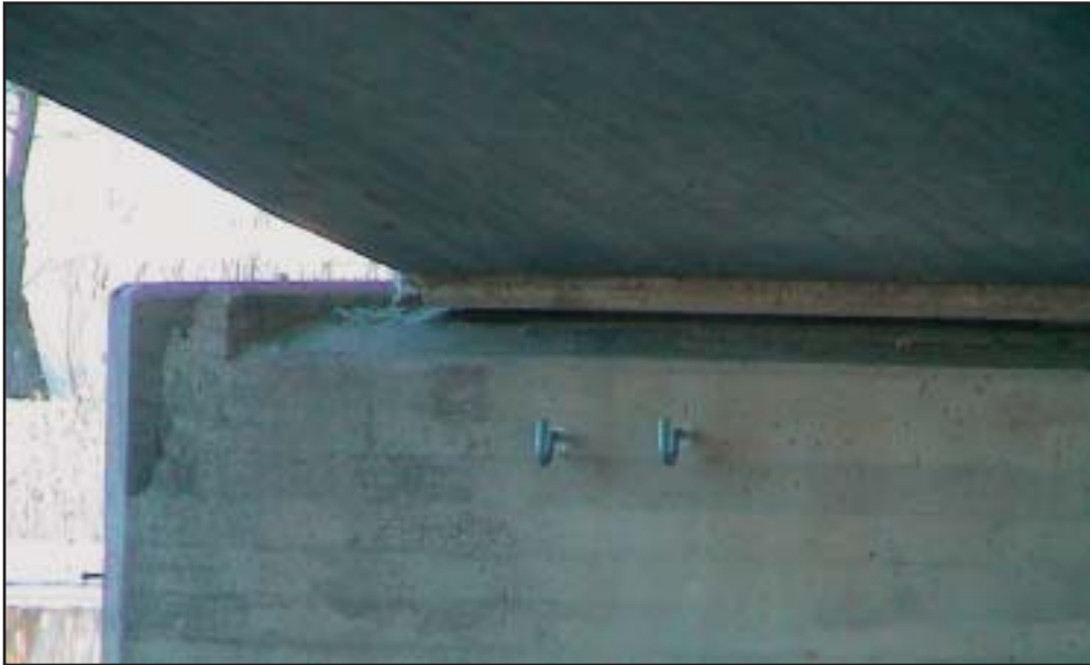
Kuva 14. Maatukeen kiinnitetyt koukut.
