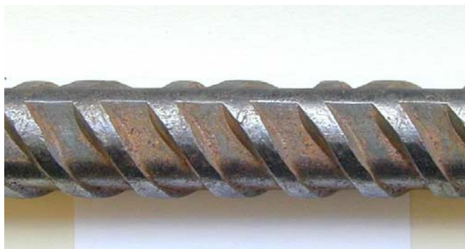
1a. Korroosioaste 0. Ennen puhdistusta.
