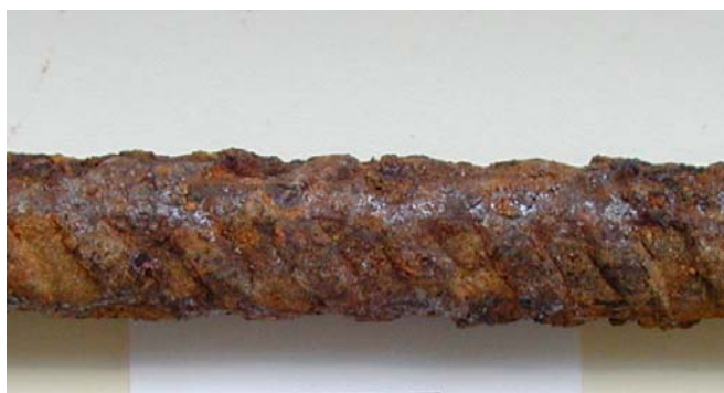
1g. Korroosioaste 3. Ennen puhdistusta.
