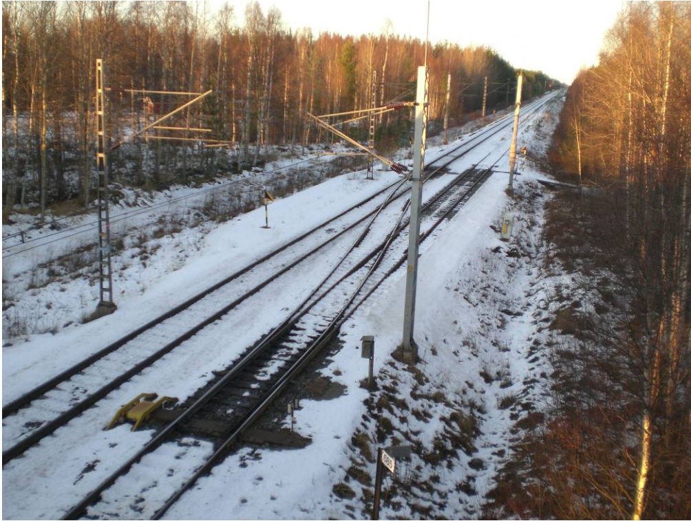
Kuva 2. Vihannin ratapiha-alueen pohjoispää (näköyhti pohjoista).
