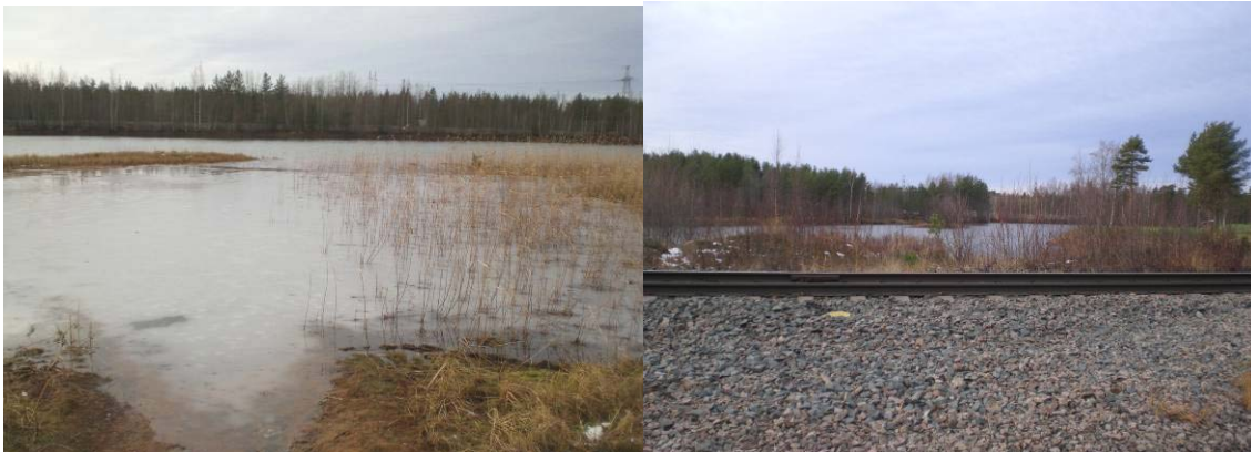
Kuva 1. Ratalinja kulkee Patamäen pohjavesialueella osittain pohjavesilammikoiden poikki.
