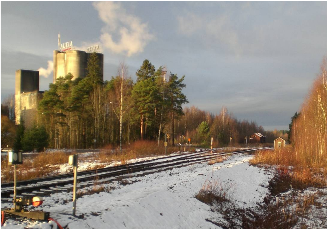
Kuva 4. Koskenkorvan ratapihalta johtaa pistoraide Altia Oyj:n tehdasalueelle.
