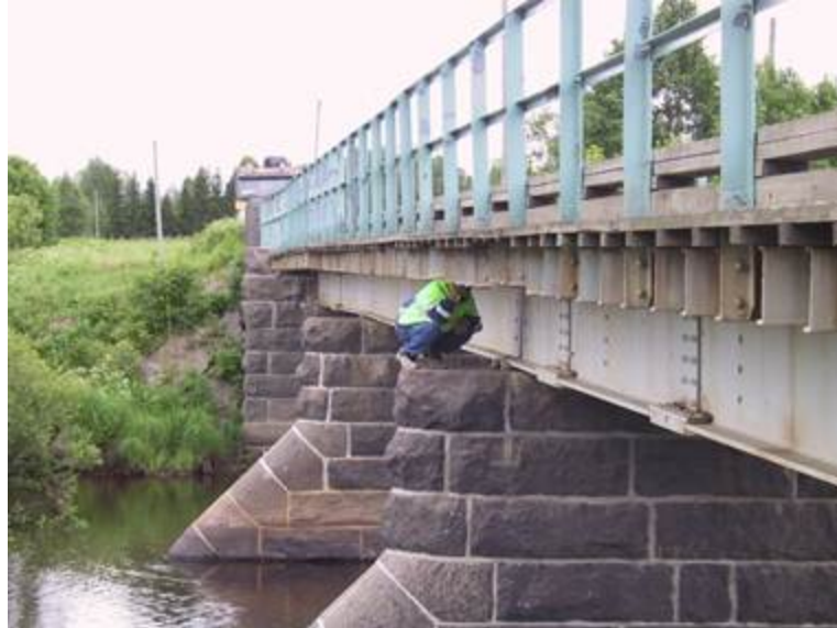
Kuva 1. Putoamissuojaus on muistettava, jos työhön liittyy putoamisvaara.
