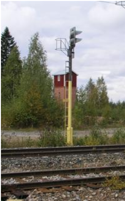
Kuva 1. Pyöreäpoikkileikkauksinen opastinmasto
