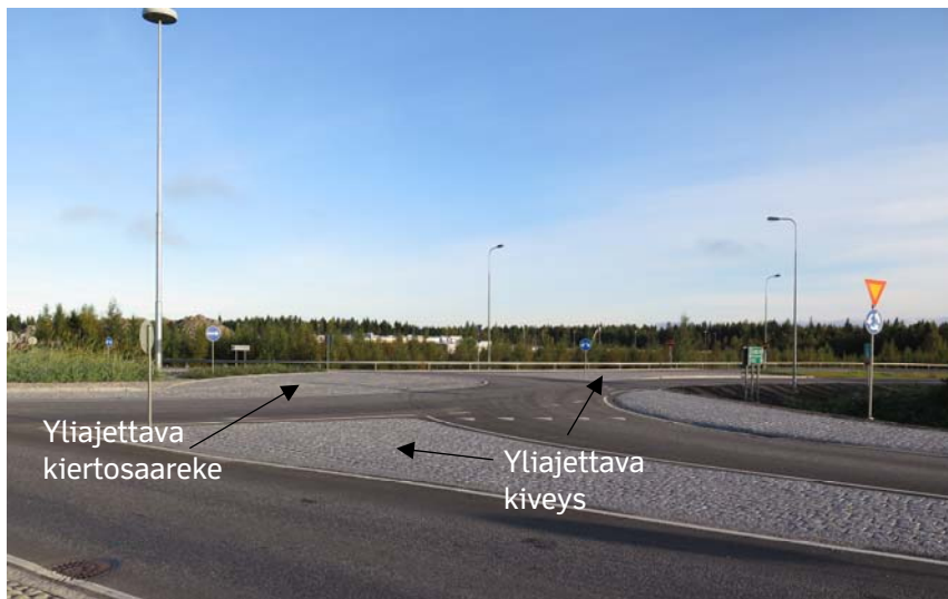
Kuva 19. Kiertoliittymä, jossa tulo- ja poistumissuunnan välinen liikennesaareke ja osa kiertoliittymän kiertosaarekkeesta on toteutettu yliajettavana.
