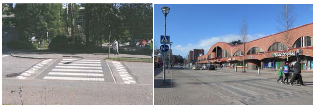
Kuva 8. Korotettu suojatie (vas.) ja korotettu alue (oik.).
