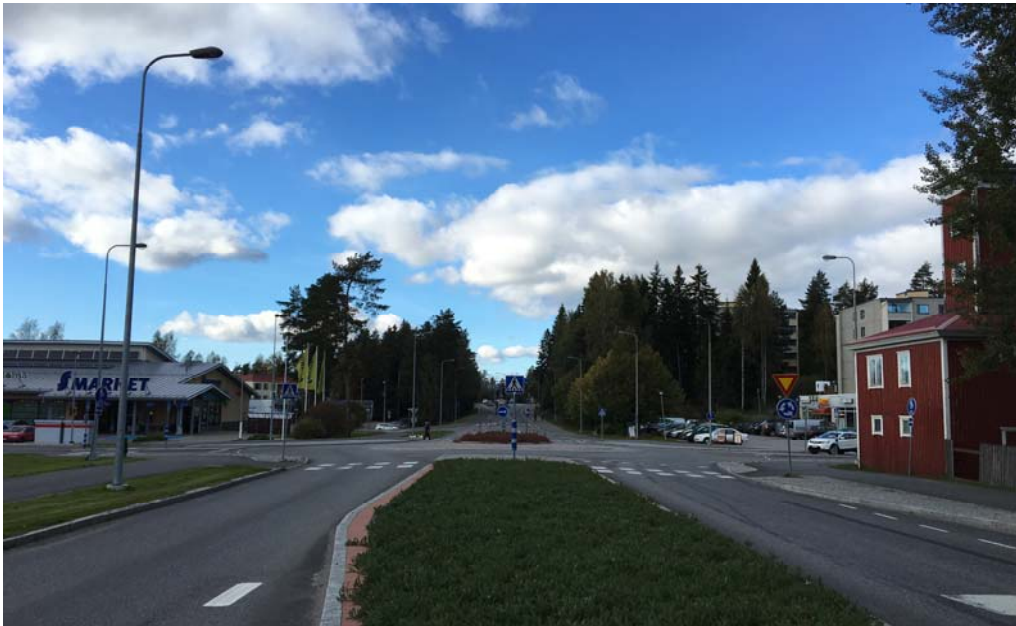
Kuva 5. Kiertoliittymä tehostamassa pääväylän liikenneympäristön muuttumista.
