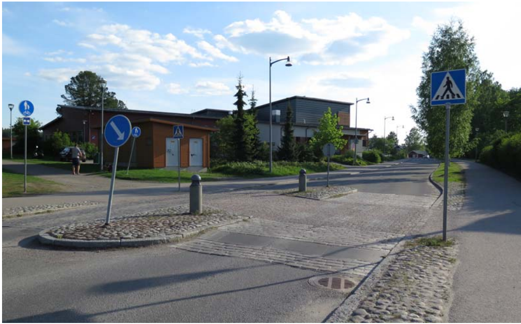
Kuva 13. Korotettu suojatie ja pyörätien jatke sekä keskisaareke.
