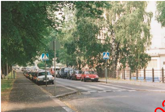
Kuva 103. Korotettu suojatie ja ajoradan kavennus yksisuuntaisella kadulla.
