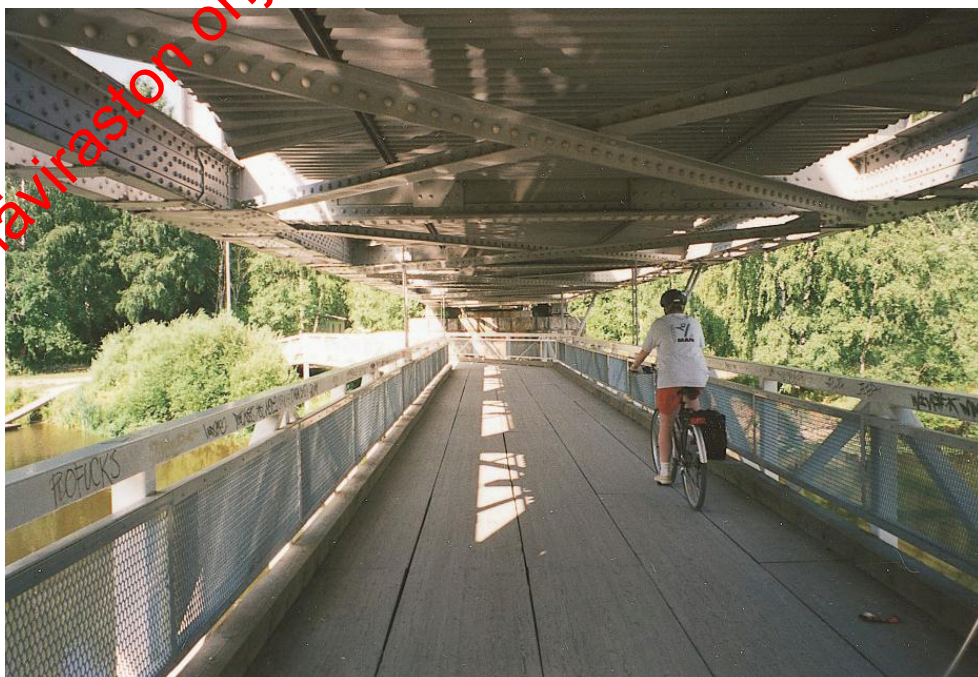
Kuva 133. Ripustettu jalankulku- ja pyöräilyväylän silta.
