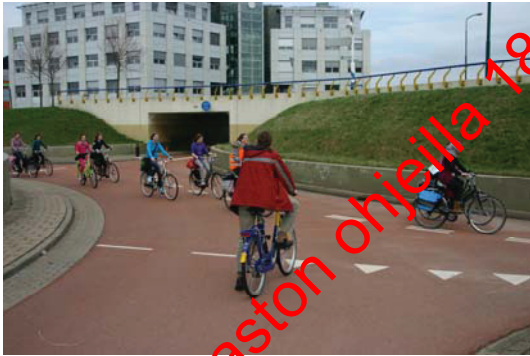
Kuva 124. Kahden pyörätien risteäminen Alankomaissa Houtenissa, jossa toisen pyörätien väistämisvelvollisuus osoitetaan kaatuun merkityllä väistämisviivalla (kuva: Kalle Väismaa). Suomessa väistämisviivan käyttö edellyttää liikennemerkkin käyttöä.
