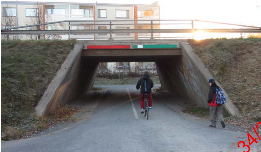
Kuva 128. Alikulku, jossa yhdistetyn pyörätien ja jalkakäytävän vastakkaiset kulkusuunnat on erotettu toisistaan värimerkinnoin.
