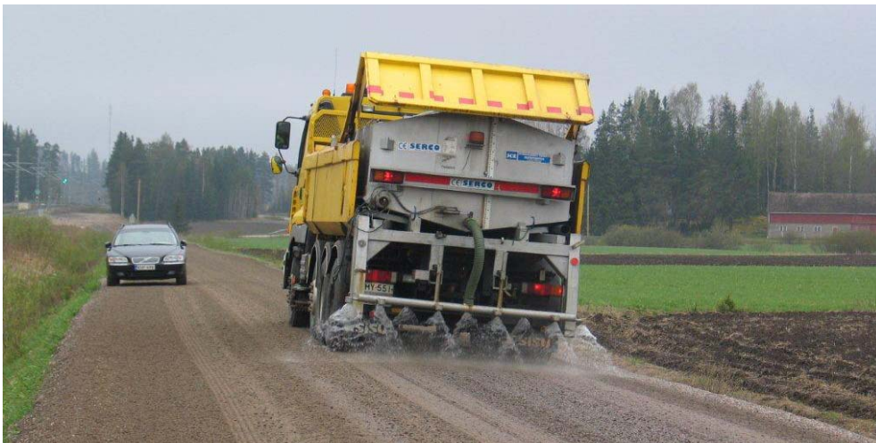
Kuva 29. Soratien pölynsidontaa suolaliuksella.
