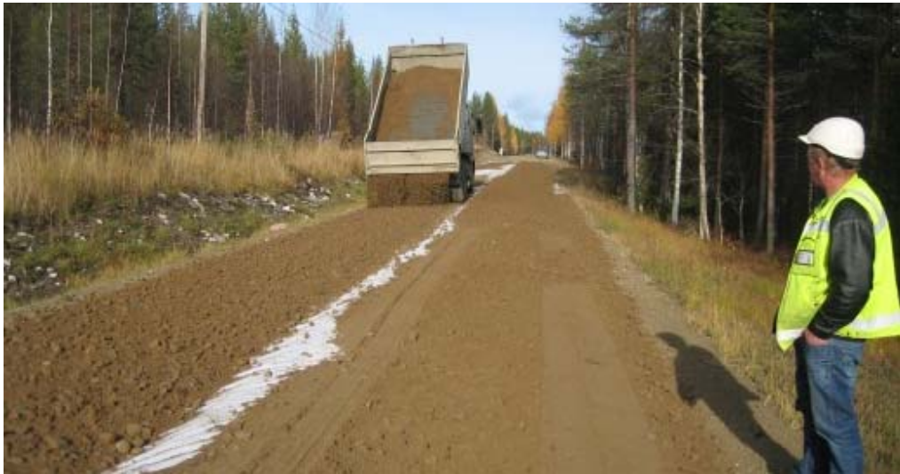
Kuva 40. Runkokelirikon korjausta.
