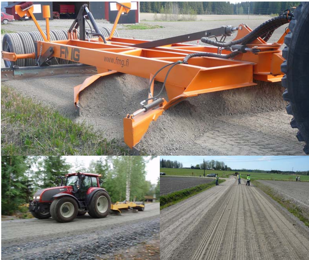
Kuva 26. Soratien muokkausta lanalla, työjälkeä tiivistää kumipyörästä.
