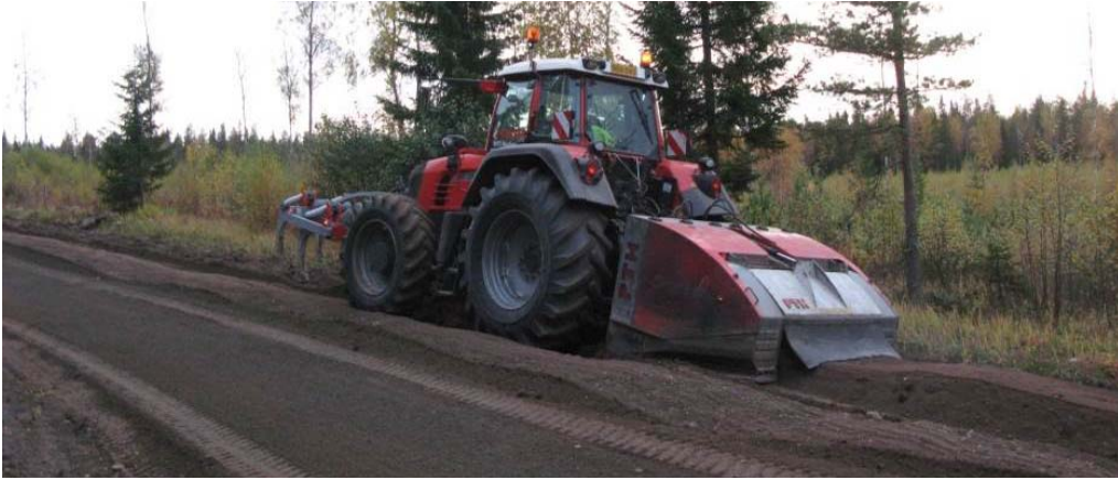
Kuva 41. Tien rungon materiaalin murskausvaihe.
