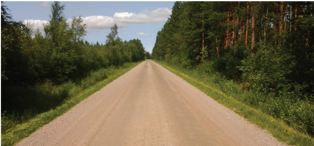
Kuva 13. Hyvin muotoiltu soratie.
