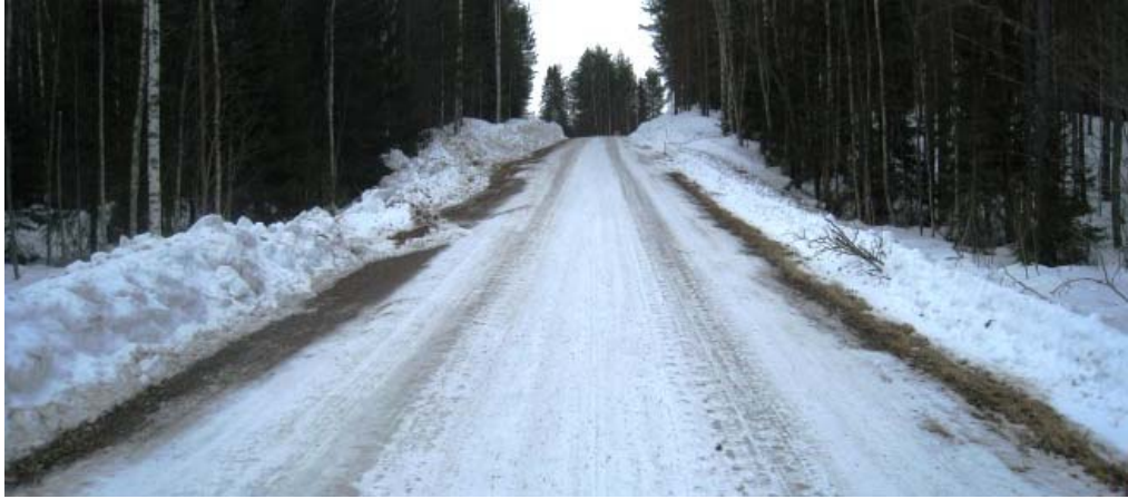
Kuva 20. Hyvin tehdyt sohjo-ojat.
