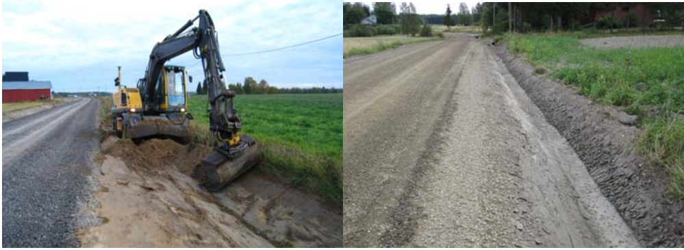
Kuva 32. Sivuojan kunnostusta ja kunnostettu sivuoja.
