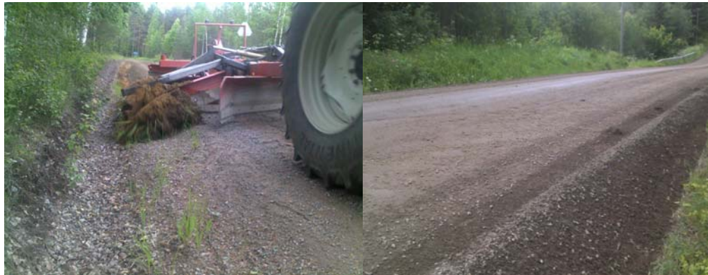
Kuva 34. Reunamateriaalin nostoa tielle lanalla.
