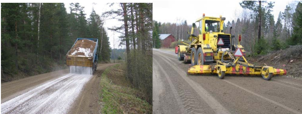
Kuva 28. Suola levitetään ja sekoitetaan, lopuksi pinta tiivistetään.
