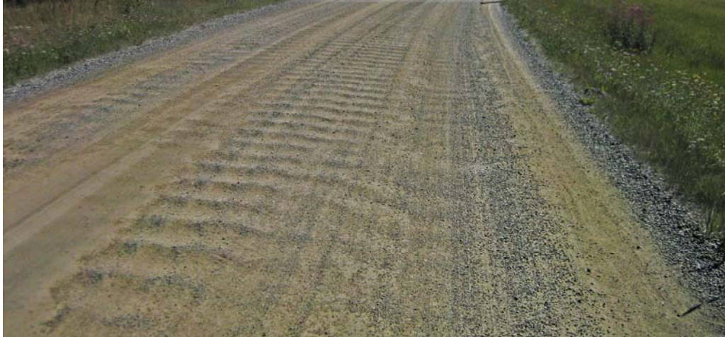
Kuva 9. Aaltomaista ajomukavuuden pilaavaa epätasaisuutta.
