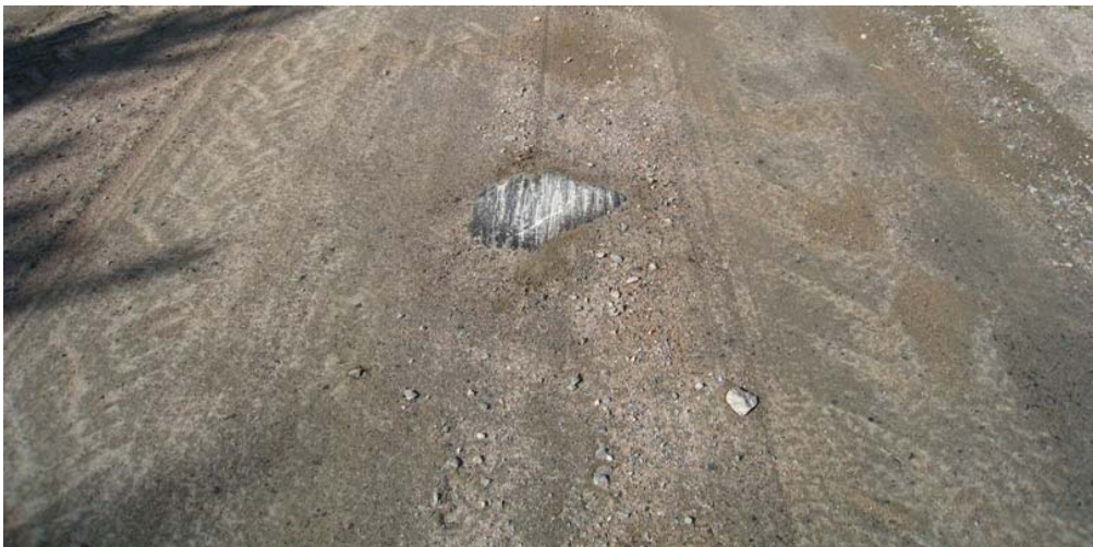
Kuva 22. Tien pintaan roudan nostama liikennettä haittaava maakivi poistetaan.
