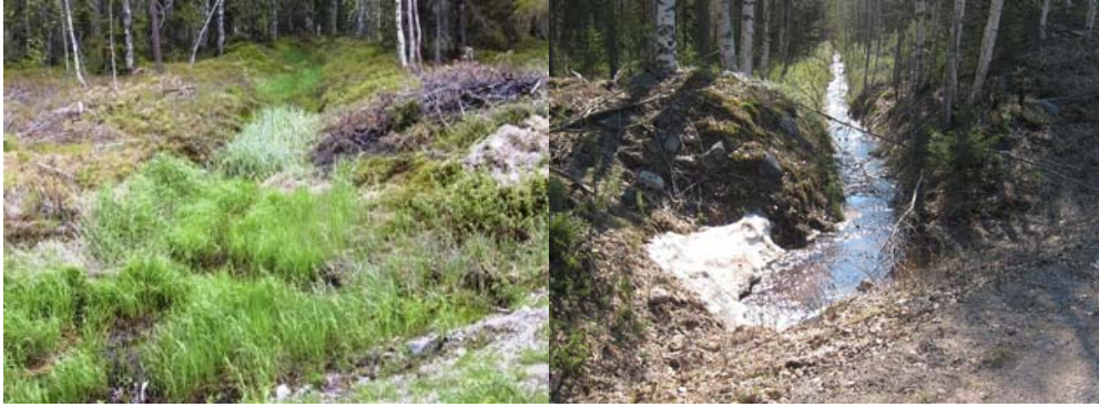
Kuva 35. Tukkeutunut ja toimiva laskuoja.
