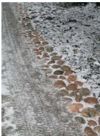
Kuva 14. Väylää reunustava kiveys osoittaa näkövammaiselle kulkusuuntaa myös talvisaikaan. Kuva Maunulan vanhustenpolulta.
