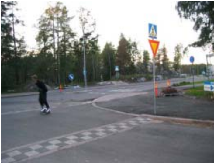
Kuva 8. Korotettu suojatie korostaa kevyen liikenteen ensisijaisuutta. Rullaluistelija pysyy samassa tasossa. Kuva Helsingistä.
