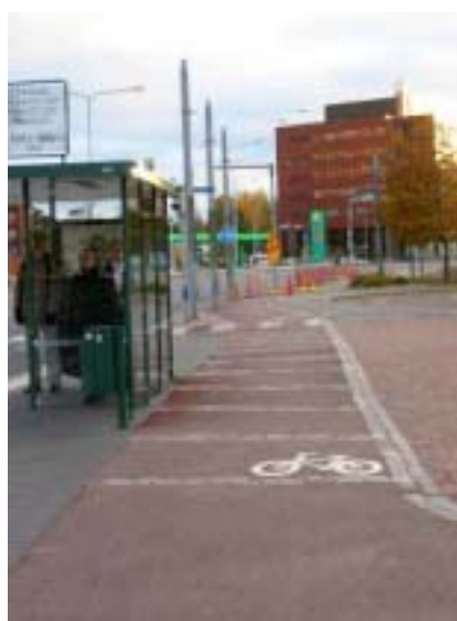
Kuva 4. Esimerkki pyörätien huomioraidoista bussipysäkin kohdalla. Ruoholahti, Helsinki.
