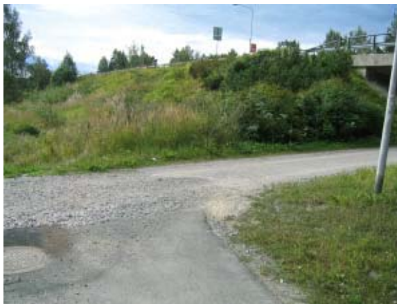
Kuva 2. Väliaikainen sorapätkä kevyen liikenteen raitilla.
