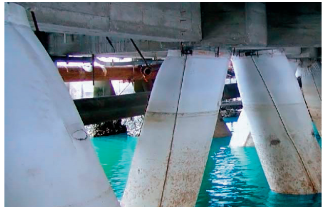
Kuva 16. Paalut korjattu pussimuotin avulla.
