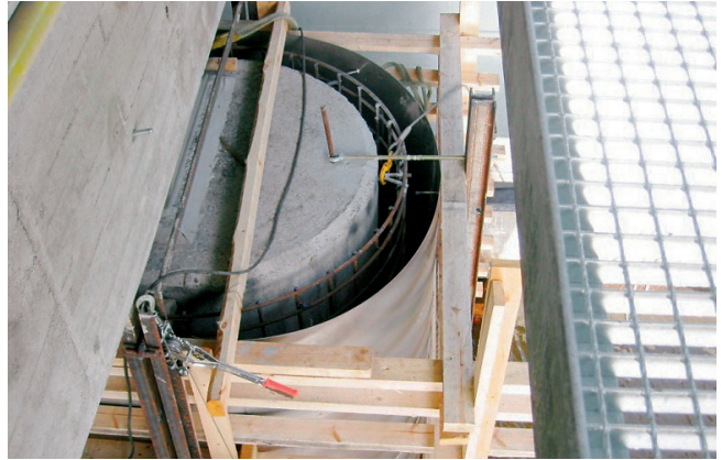
Kuva 13. Rauditusverkolla vahvistettu välituki.
