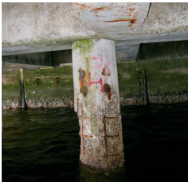
Kuva 2. Betonin eroosion ja raudituksen korroosion vaurioittama paalu.
