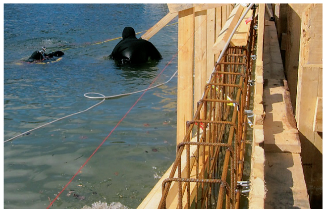
Kuva 14. Laiturin teline- ja muottirakenne.
