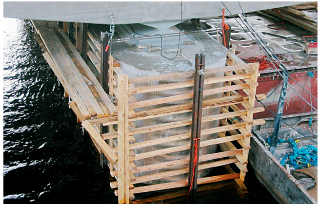
Kuva 10. Välituen telinerakenne.
