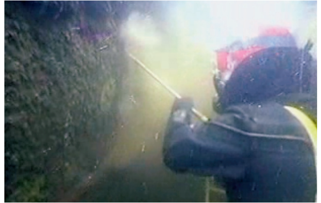
Kuva 12. Korjausalustan puhdistus käynnissä.
