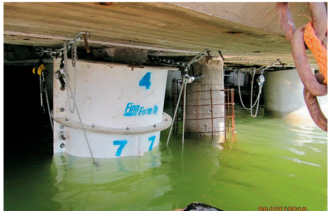
Kuva 15. Korjattavan paalun ympärille ripustettu lasikuitumuotti.
