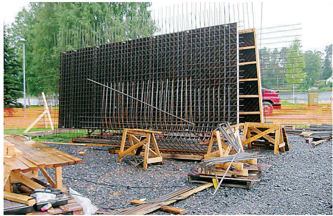
Kuva 9. Valmiiksi raudoitettu valumuotti.
