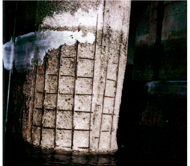
Kuva 5. Betonin eroosioaurio pilarissa.
